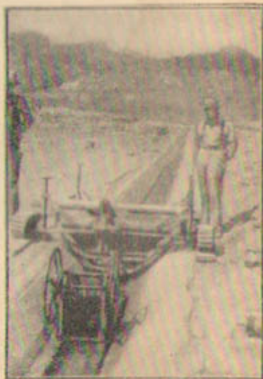
Рис. 39. Машина для бетонирования с производительностью 240 м 2 бетонной облицовки в сутки.
