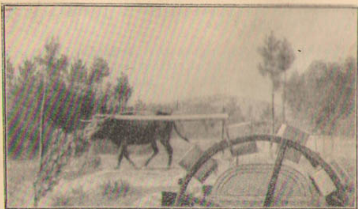
Р и с. 48. Типичная португальская установка для подъема воды, приводимая в действие быком, который с завязанными глазами ходит по кругу.
