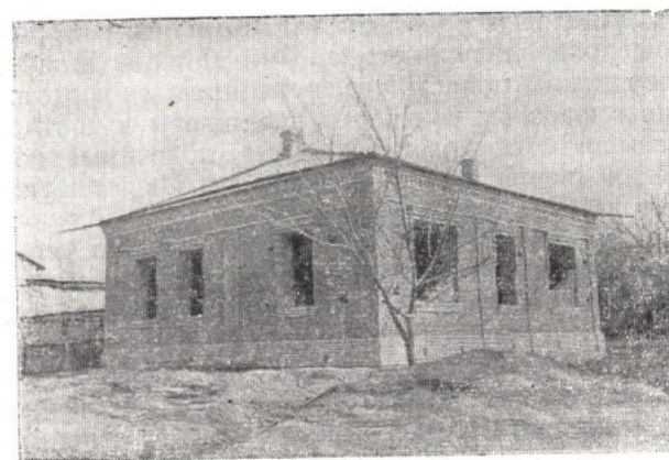
Рис. 5. Строительство жилого дома по типовому проекту.
