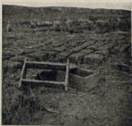
2. Форма для приготовления са- манного кирпича, без дна. Аул I, II-ой Адаевск. вол. Адаи.
