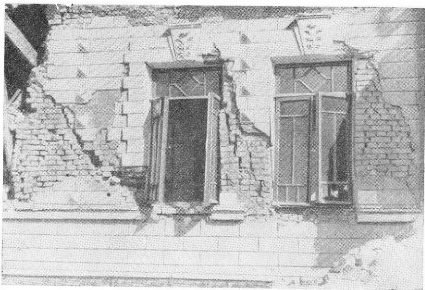
Рис. 121 Разрушение простенков
