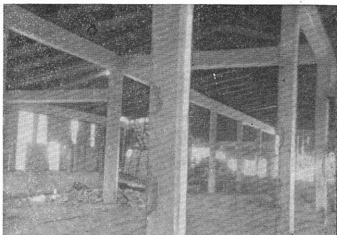
Рис. 159. Сохранившийся железобетонный каркас верхнего этажа
