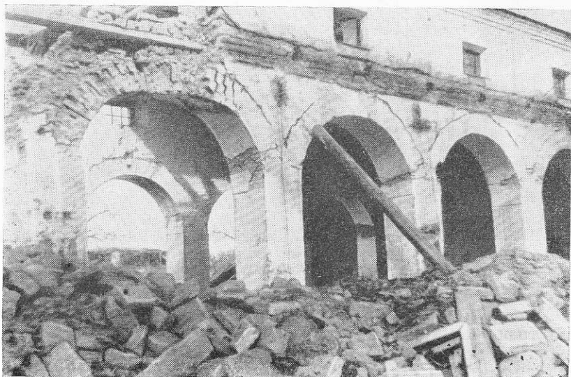
Рис. 181. Часть фасада табачной фабрики. Характер повреждения арок
