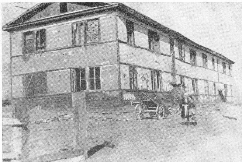
Рис. 197. Хорошо сохранившийся 2-этажный деревянный каркасный дом ашхабдского горводопровода
