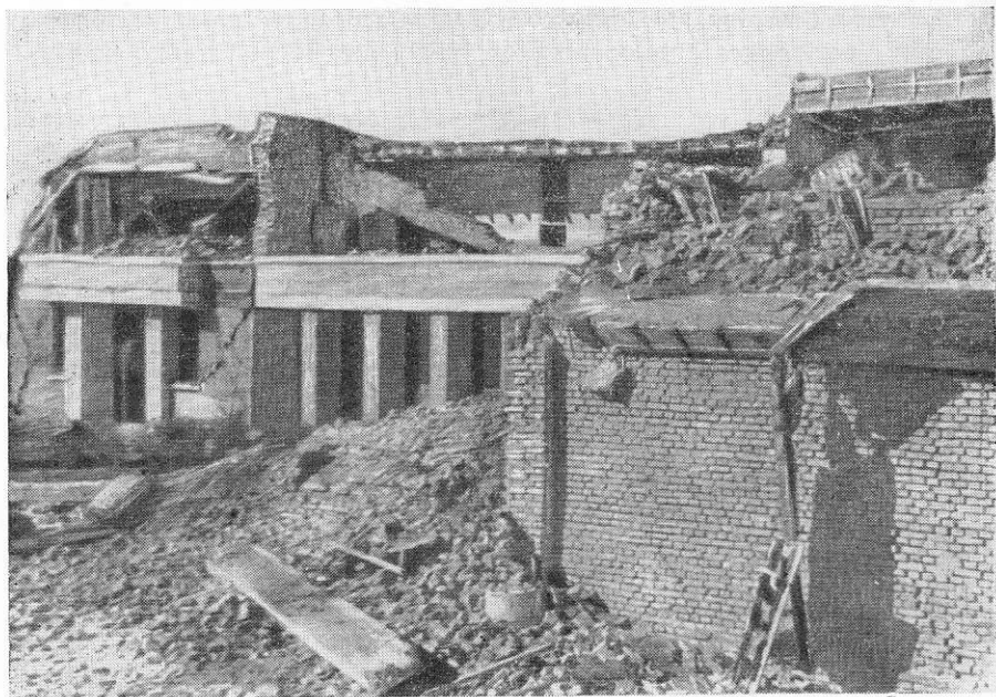
Рис. 104. Разрушения здания клуба
