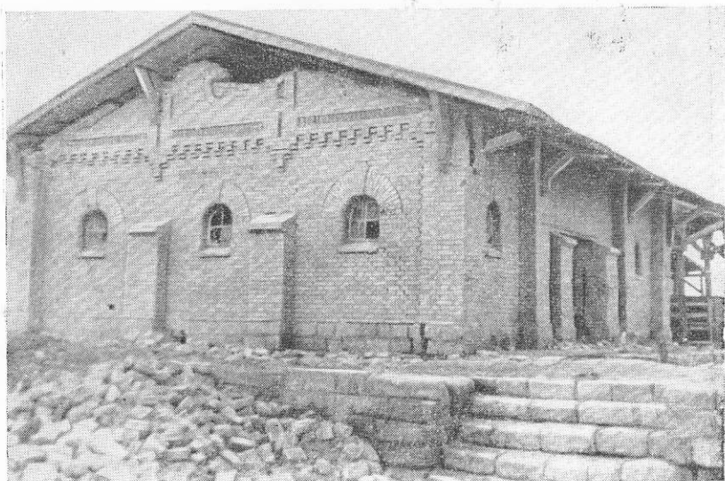
Рис. 210. Здание пакгауза после землетрясения
