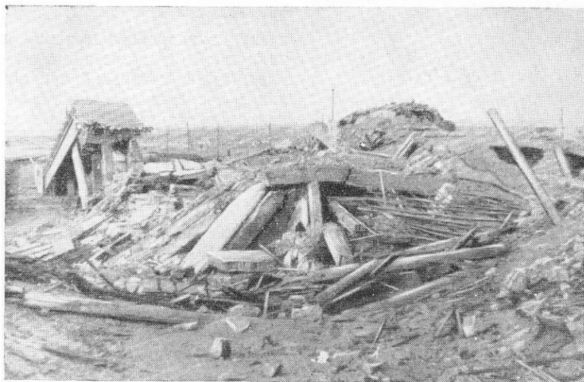
Рис. 173. Разрушения мясокомбината со стороны взгона
