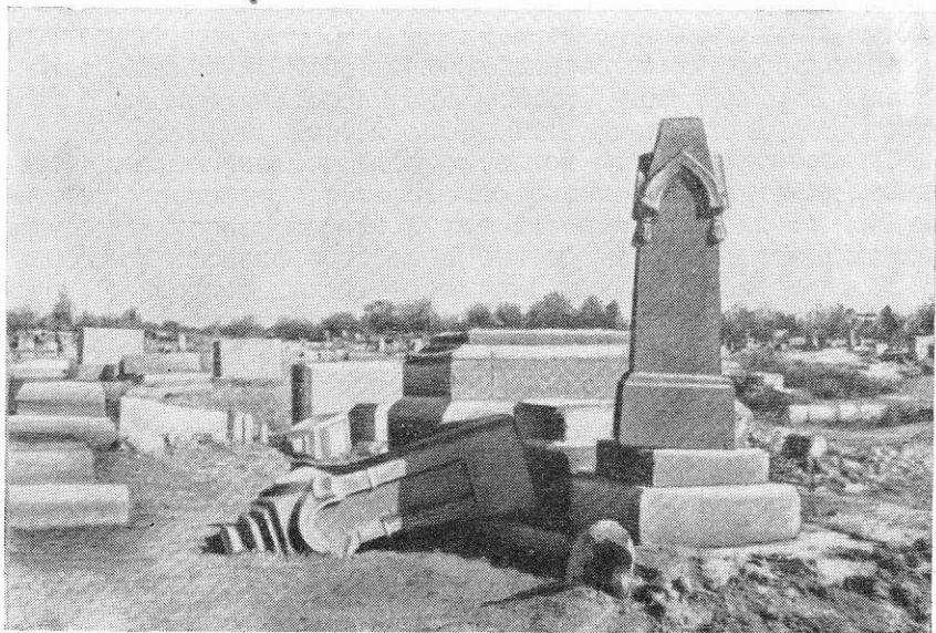
Рис. 17. Надгробные памятники, сдвинутые и повернутые на постаменте или опрокинутые
