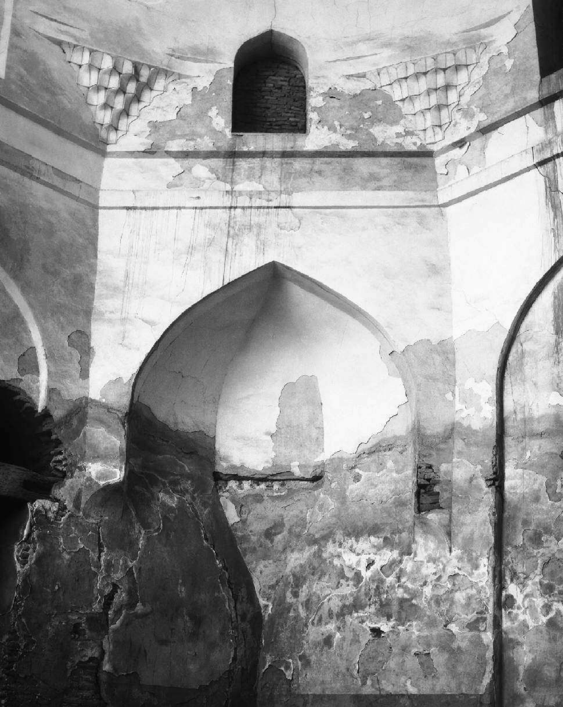
24. Интерьер гур-ханы. Арочный парус. (1952 г.) 24. Intérieur du gûr-khâna. La trompe. (1952) 24. Interior of the gûr-khâna. The squinch. (1952)
