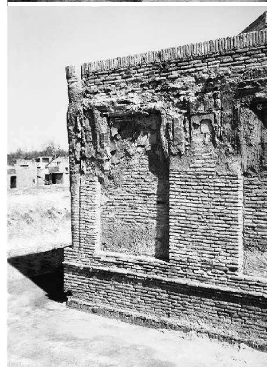
Западная часть. Partie ouest. Western part.
