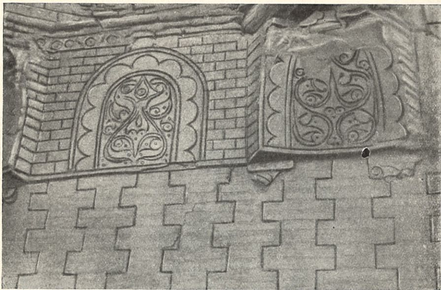
Рис. 13. Резной штукатур на западной стене среднего мавзолея
