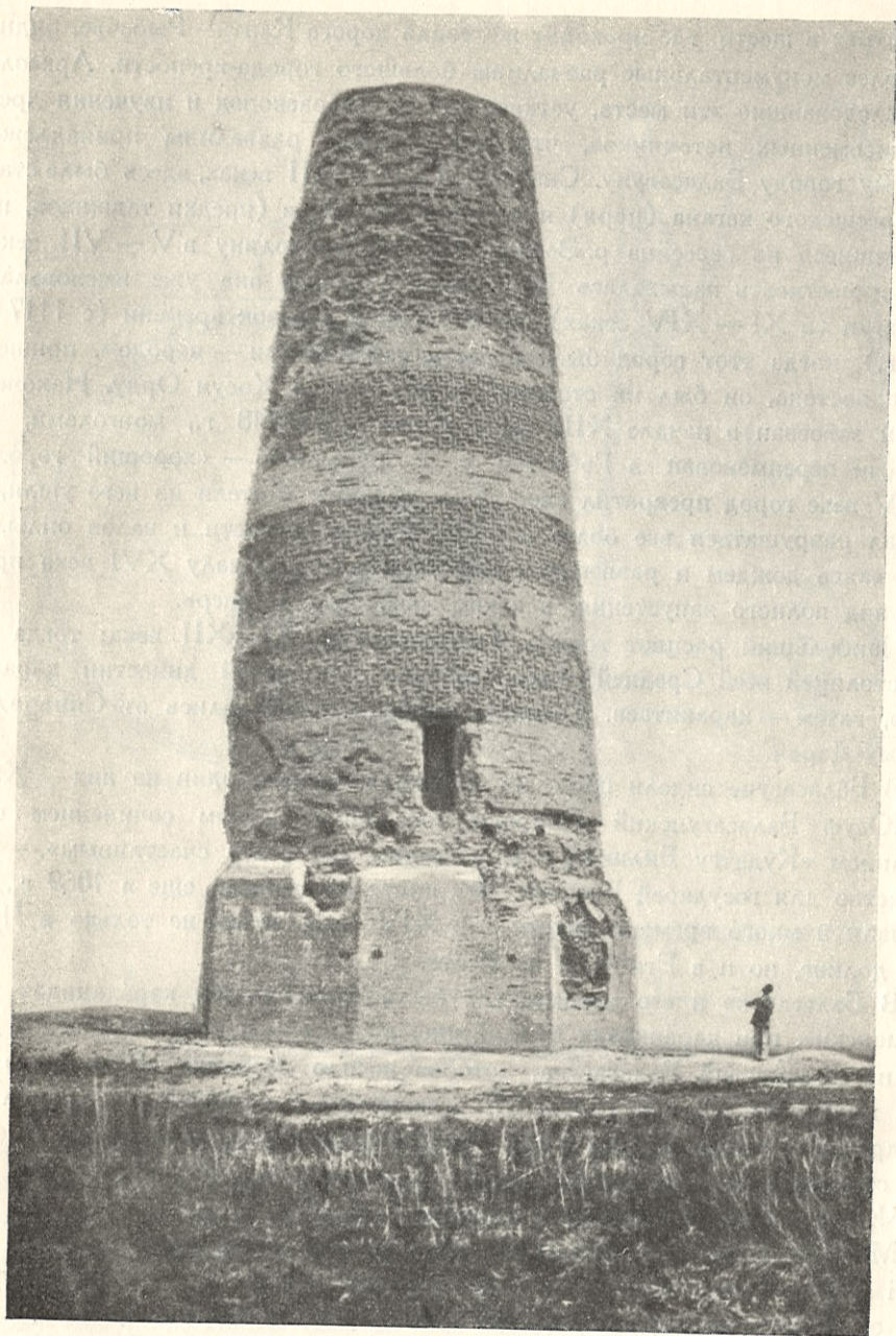
Рис. 1. Башня Бурана. Общий вид
