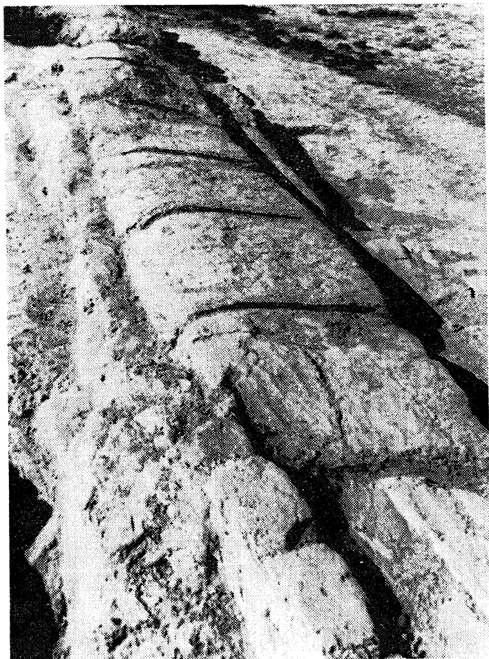
Рис. 20. Пахсовая кладка стен цитадели Куйрук-тобе. VII — первая половина IX в.
