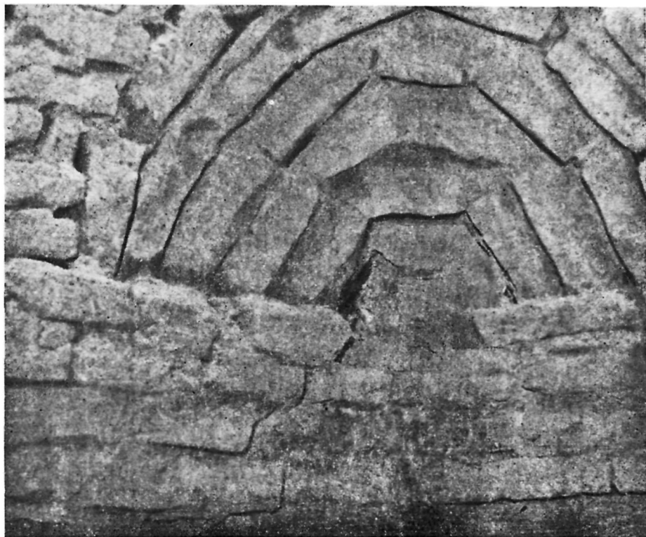
Табл. 12. Кафыркала. Цитадель. Тромп в помещении I
