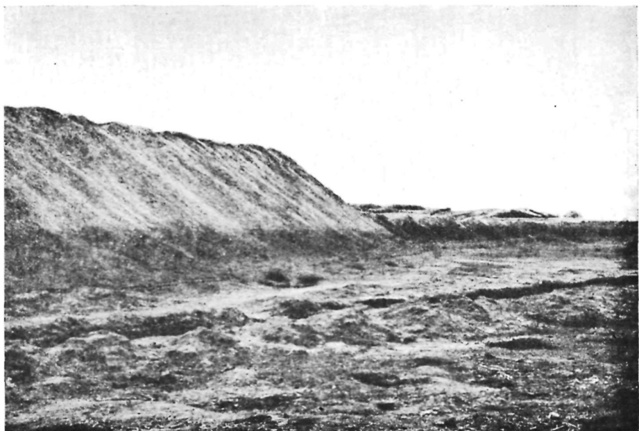
Табл. 1. Кафыркала. Северный фасад
