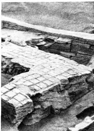
Рис. 126. Останец конструкции пандуса
