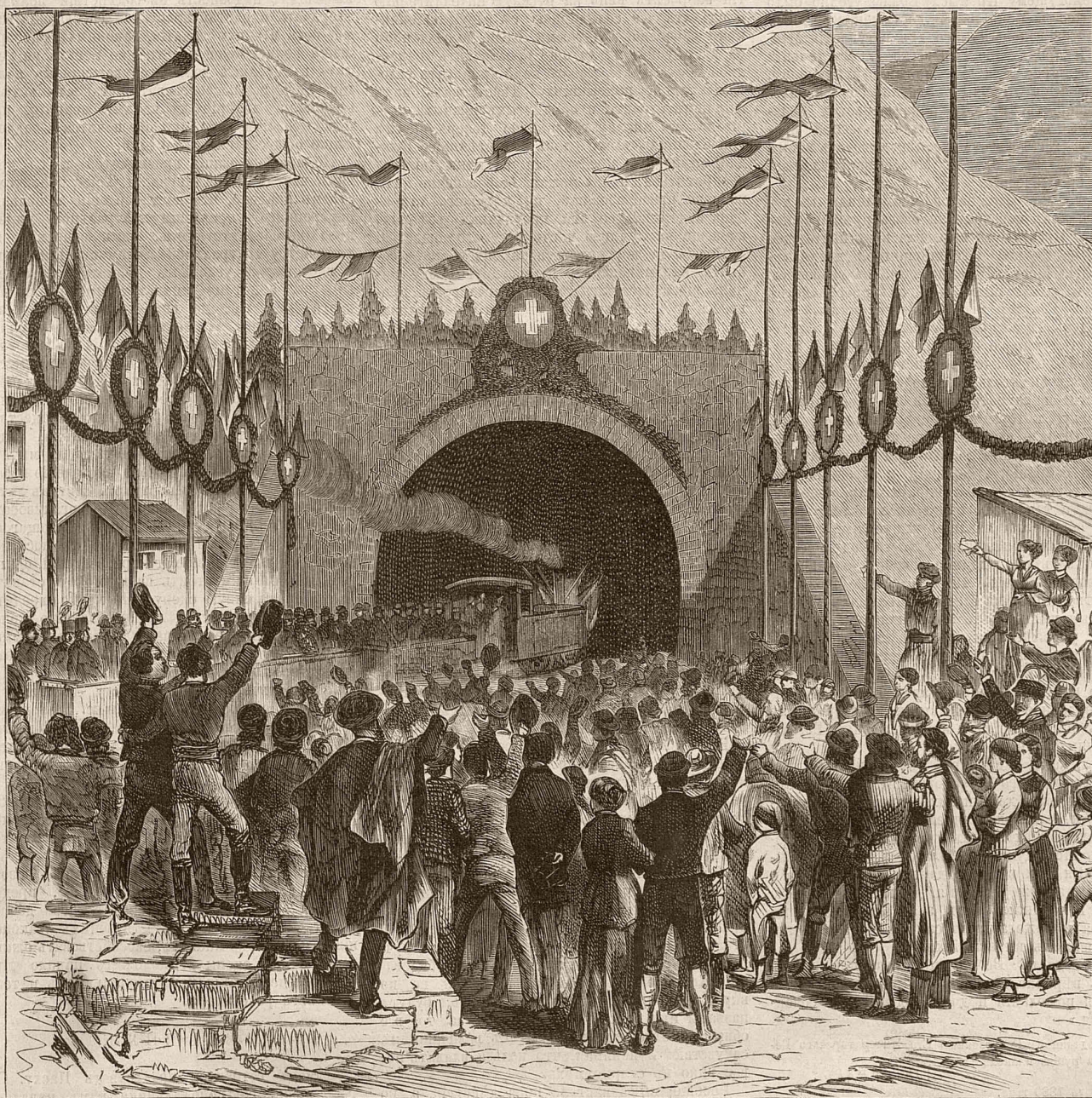
Прорытіе сень-готтардскаго туннеля. — Первый поѣздъ инспекціи дороги черезъ туннель, изъ Гешенена въ Айролу, 2-го марта.
