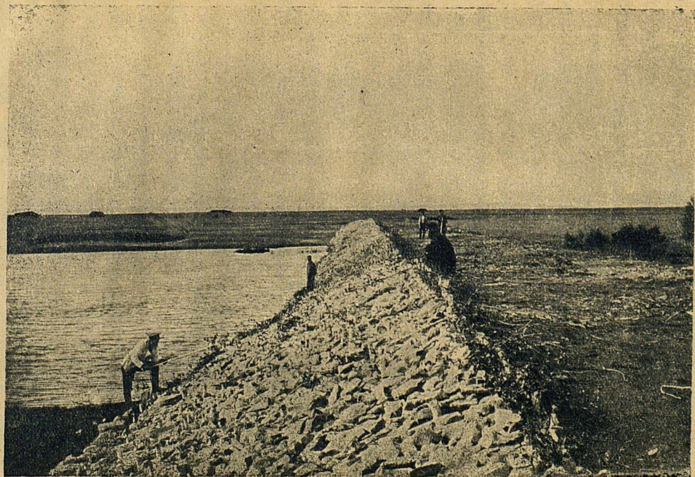
Плотина на переселенческомъ участкѣ.
