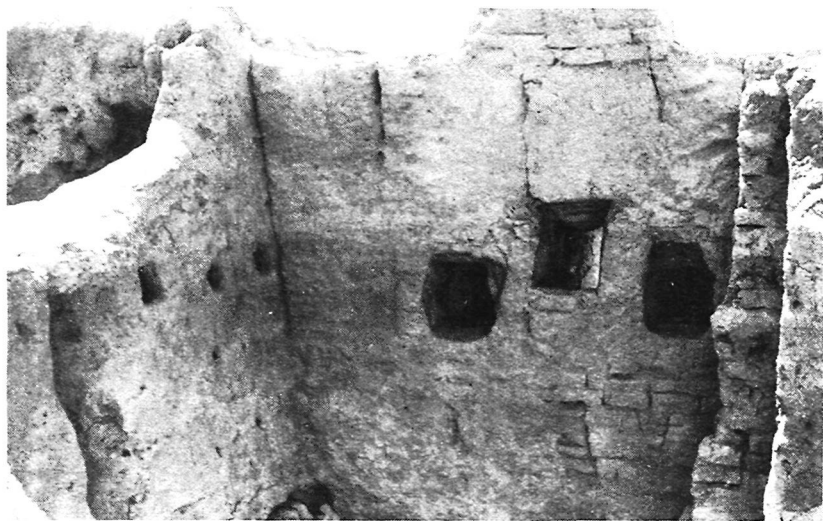
Рис. 72. Угол в месте стыковки фасадных стен двух зданий VII в. (объект XVI). Видно окно из помещения 83 и гнезда от крепления навеса.
