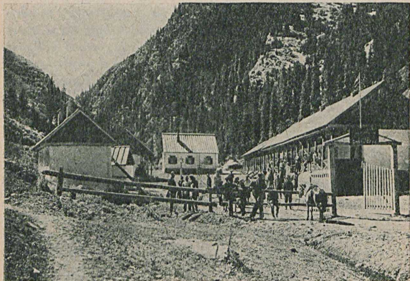
Курорт Джеты-Оуз. Общий вид; налево—здания с ваннами, направо—помещения для больных; склоны гор покрыты тянь-шаньской елью.]
