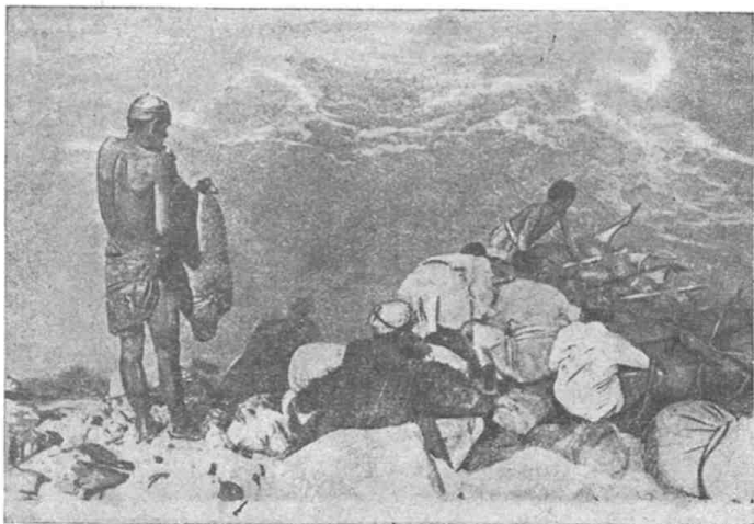
Рис. 42. Постройка плота из торсунов.
