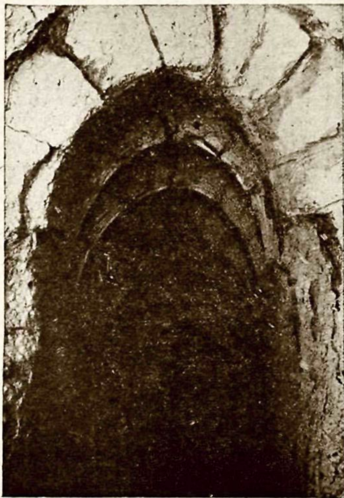
Рис. 45. Ступенчатый свод в большом сырцовом здании (Кыз-Кала Малая) в Старом Мерве
