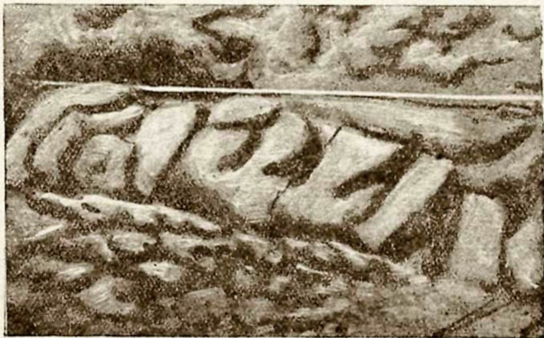
Рис. 17. Сырцовые блоки в кладке крепостной ограды.
