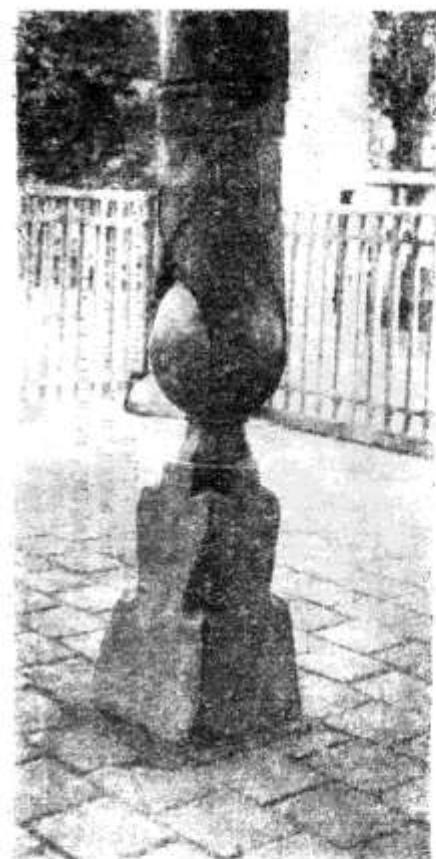
Рис. 100. Колонна на айване мечети Ходжа-Джон-Ходжа. Около 1870 г. Яблоко типа тарбузи.
