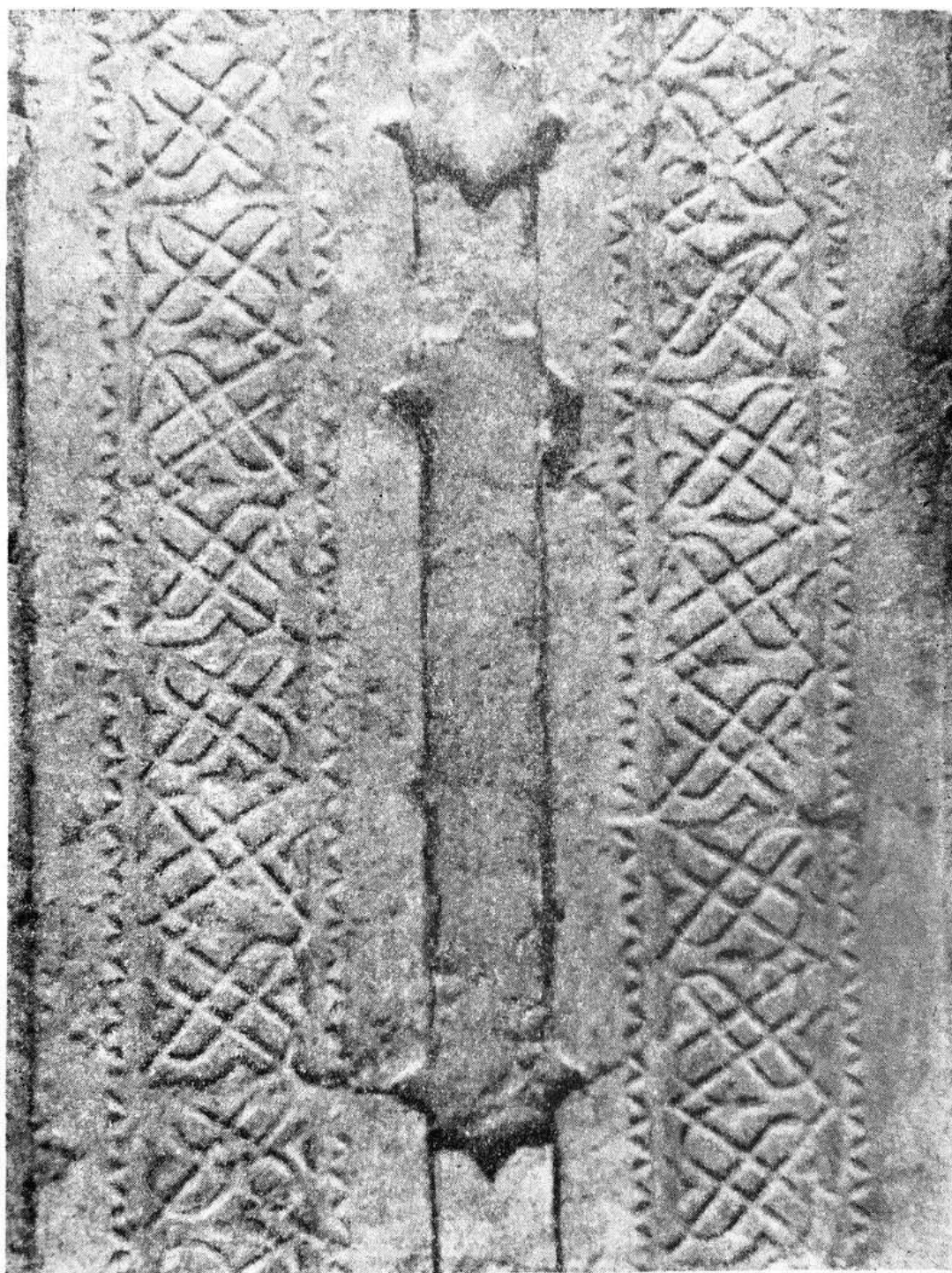
Рис. 52. Узор, оттиснутый штампом по тузгоковой штукатурке, в доме Махдихана Кори в гузаре 2-й Ургути.
