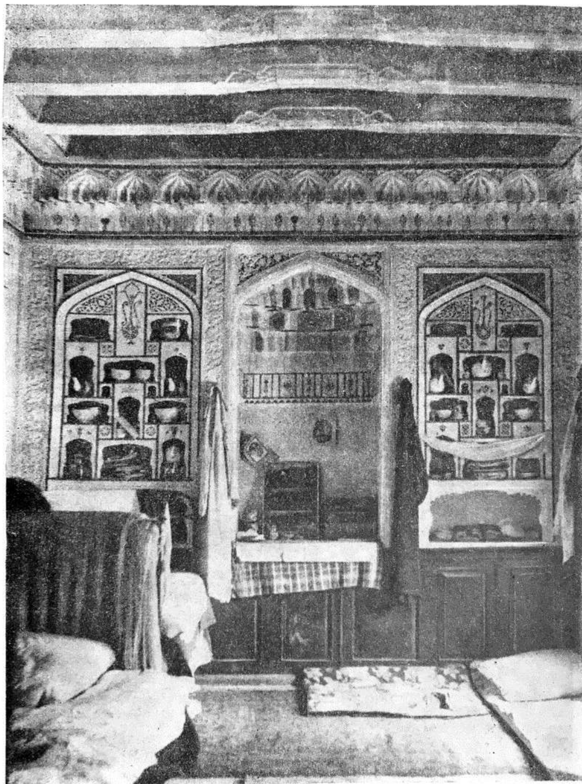
Рис. 49. Торцовая стена с нишами в доме Ходжи Мама-Юнусова в гузаре Ёмини. Внизу деревянная панель «сандика». Работы по ганчу выполнены в начале XX в. бухарцем усто Абдуджалилом.
