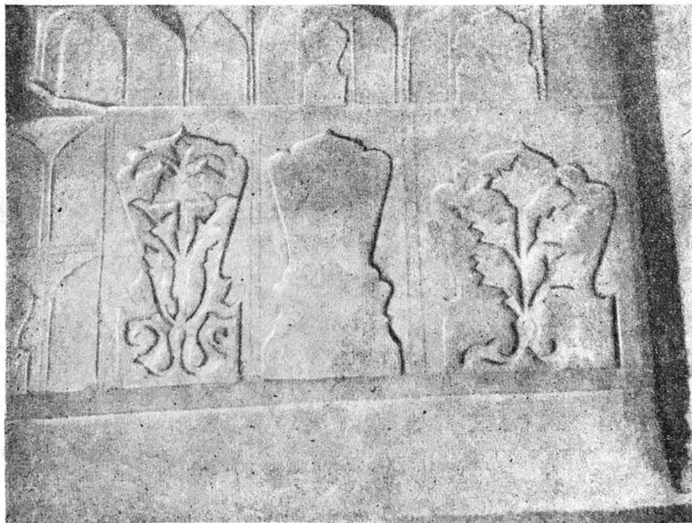
Рис. 54. Небольшие резные панно без разделки поверхности резьбы на щёке ниши михраба в зимнем помещении мечети Боги-Майдон. Середина XIX в.
