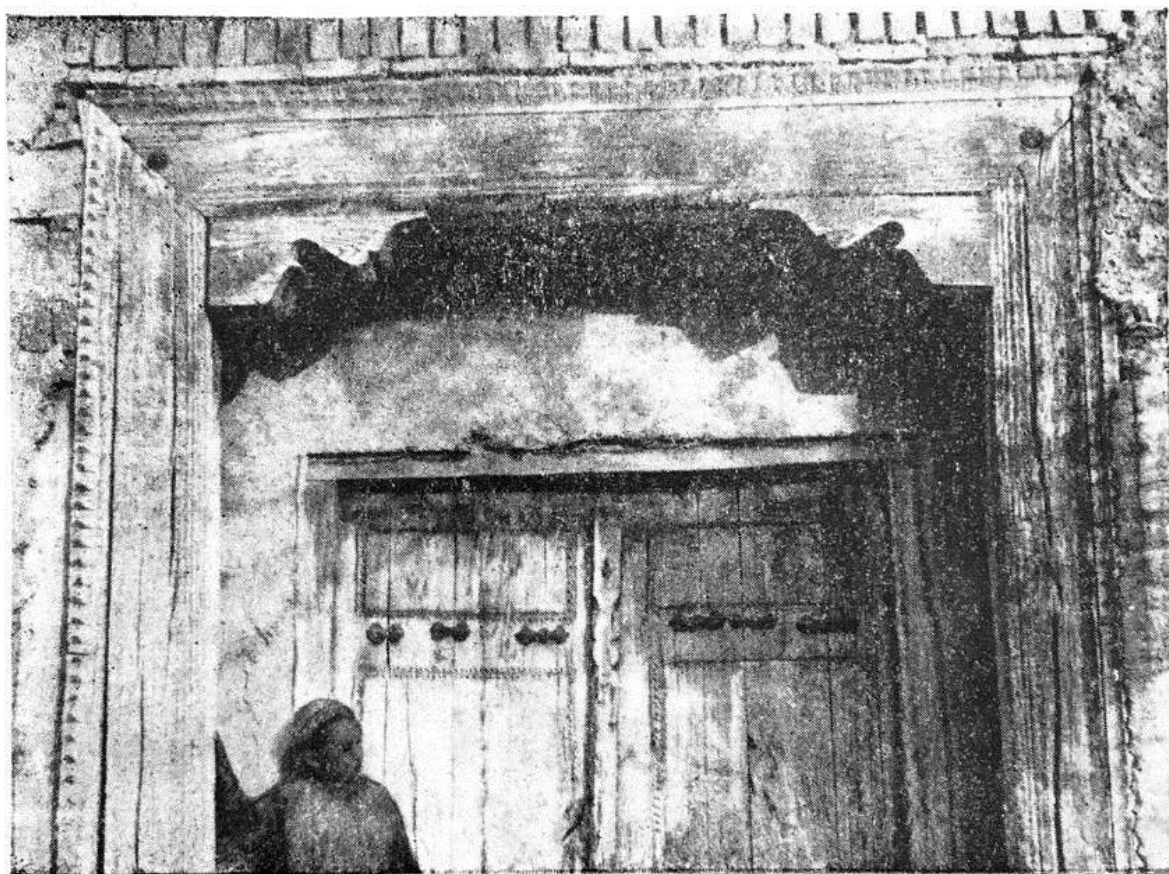
Рис. 107. Подбалка типа сарбухсри в оформлении дарвозахоны—портика над входом во двор жилого дома. Начало XX в.
