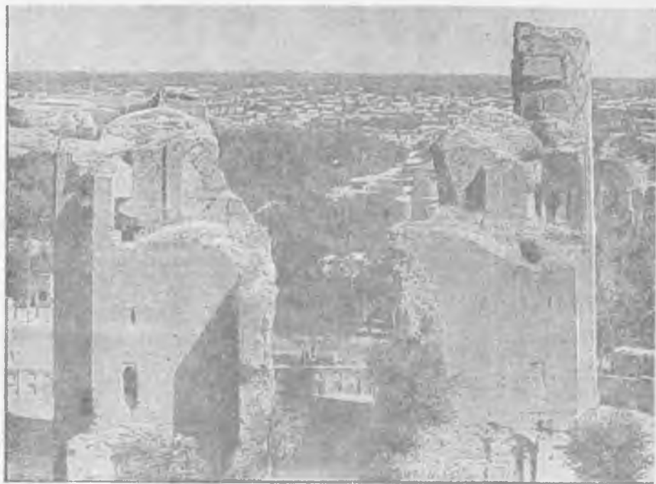
Рис. 4. Тыльные конструкции входного портала (фото Л. Ю. Мамьковской).
