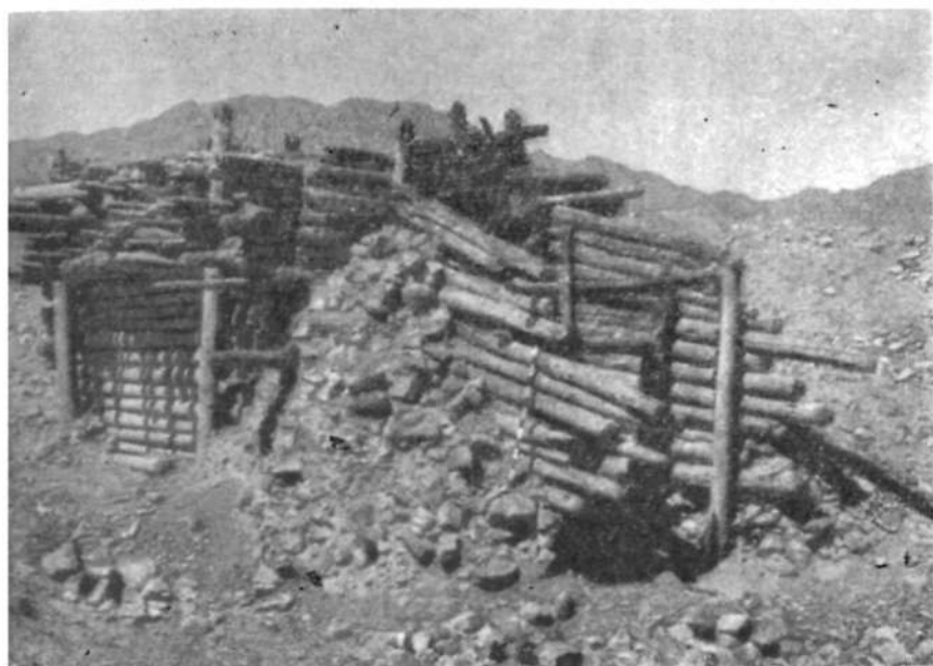
Рис. 14. Южный фасад усыпальницы.
