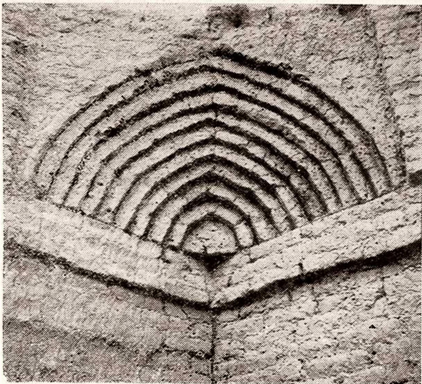
Рис. 13. Угловой тромп мавзолея Кыз-биби.
