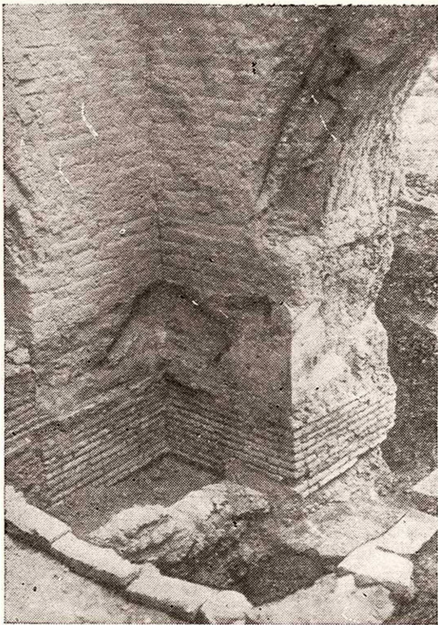
Рис. 12. Северо-восточный угол мавзоля Кыз-биби. Внизу виден цоколь из жженных кирпичей.
