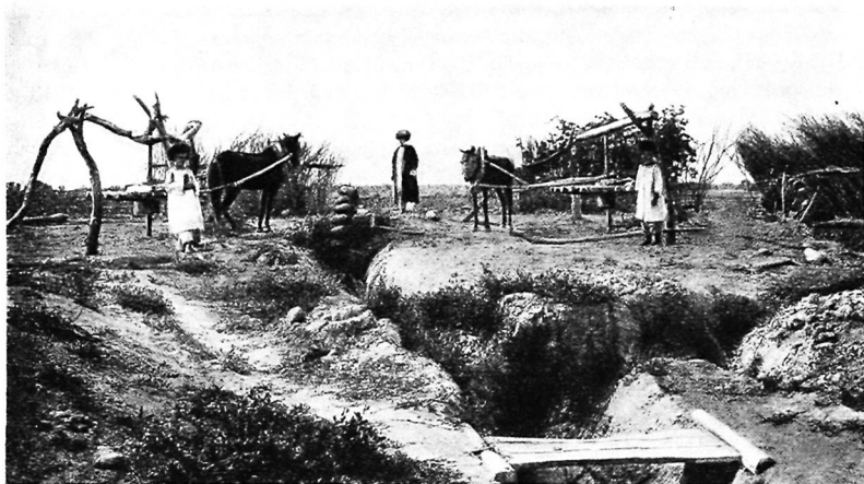
Рис. 2. Двойной чигирь, вращаемый лошадьми. (Из материалов Переселенческого управления)
