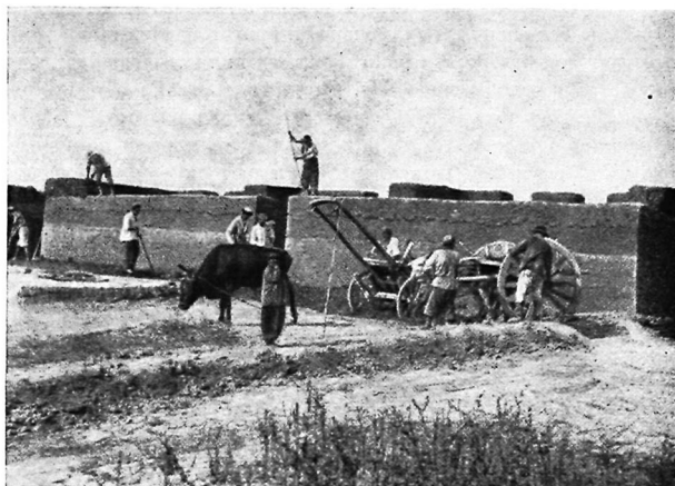
Рис. 34. Постройка дома из пахсы
