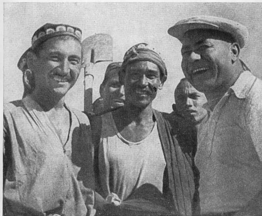
Строители Большого Ферганского. 1939 г.
