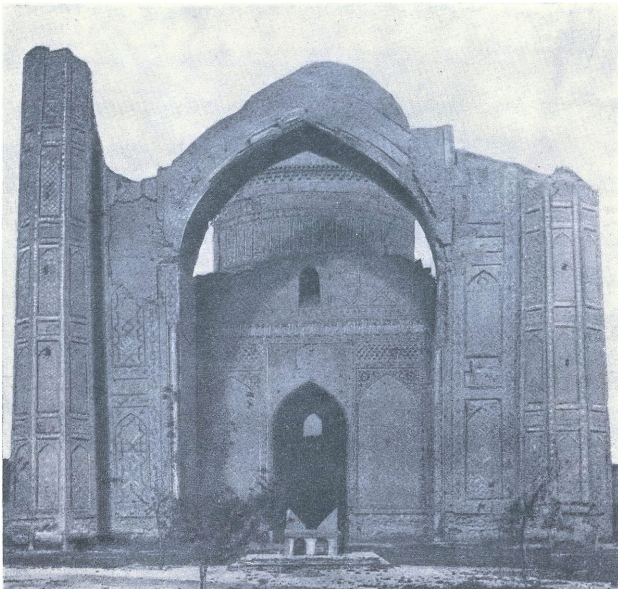
Рис. 24. Восточный фасад главного здания мечети.
