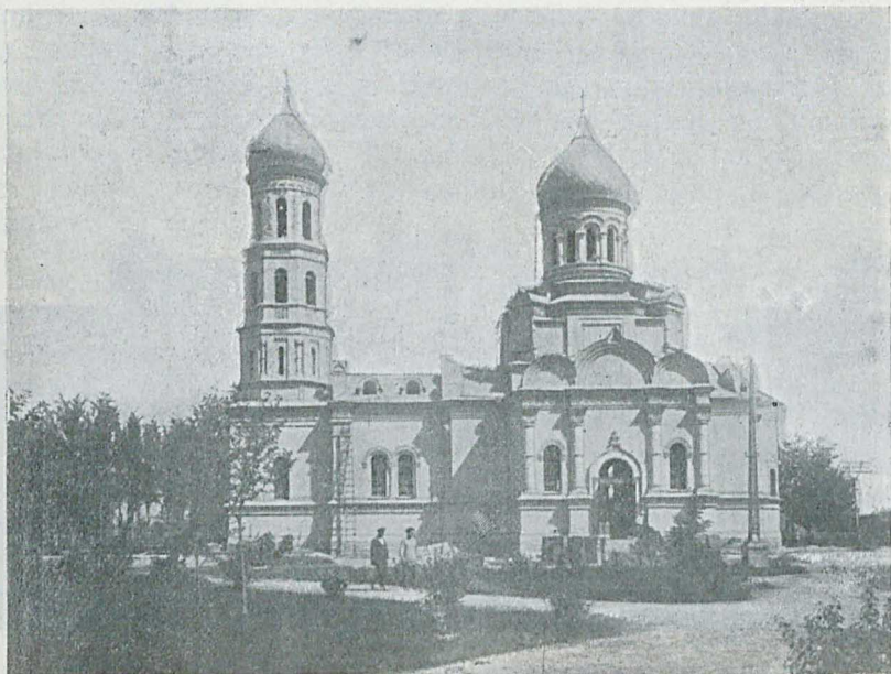
Церковь Благовѣщенія на станц. Ташкентъ.
