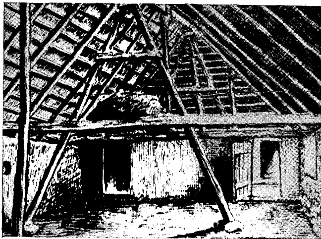
Рис. 8. Конструкция крыши датского крестьянского дома (вид изнутри)
