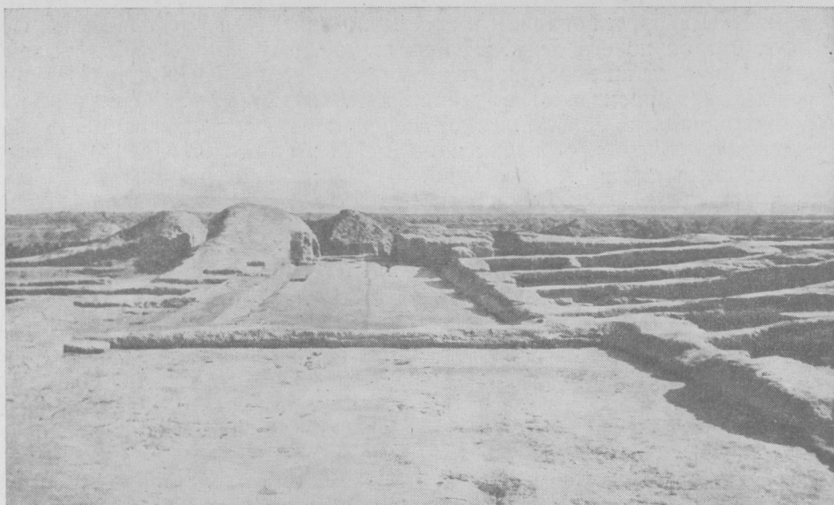
Рис. 8. Безымянный замок. Вид с севера после раскопок
