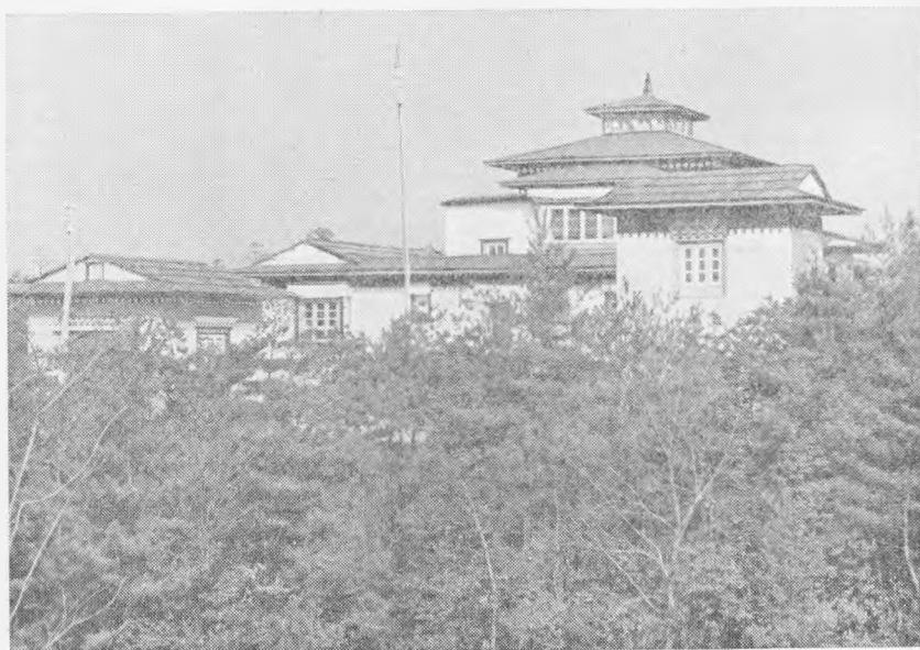
Рис. 6. Строительство непальского монастыря в основном уже закончено
