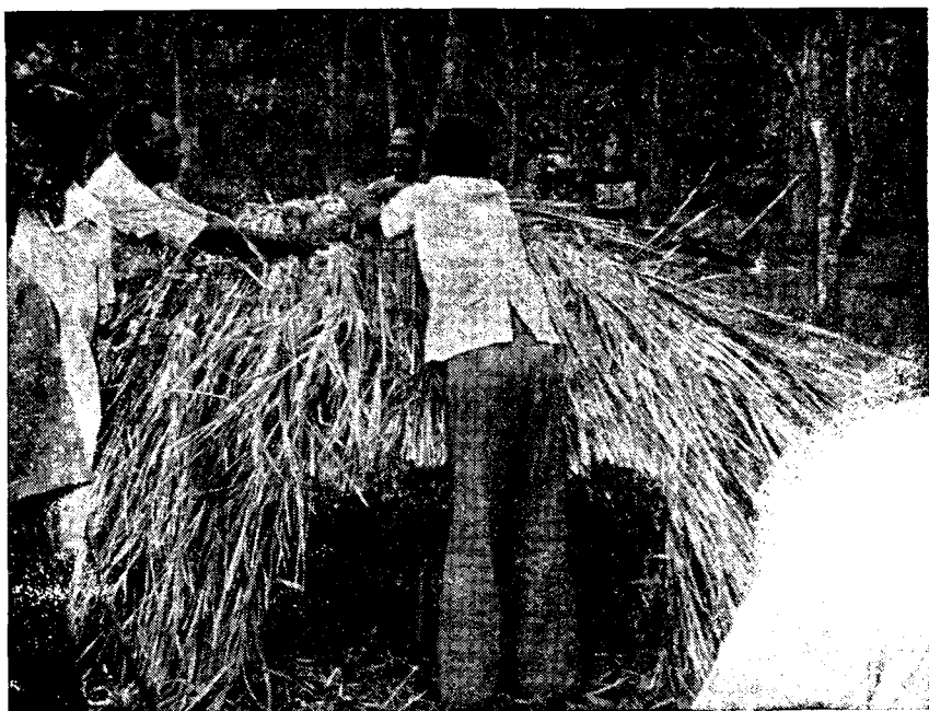
Рис. 6. Покрытие тростником каркаса крыши хижины с Тонгоа
