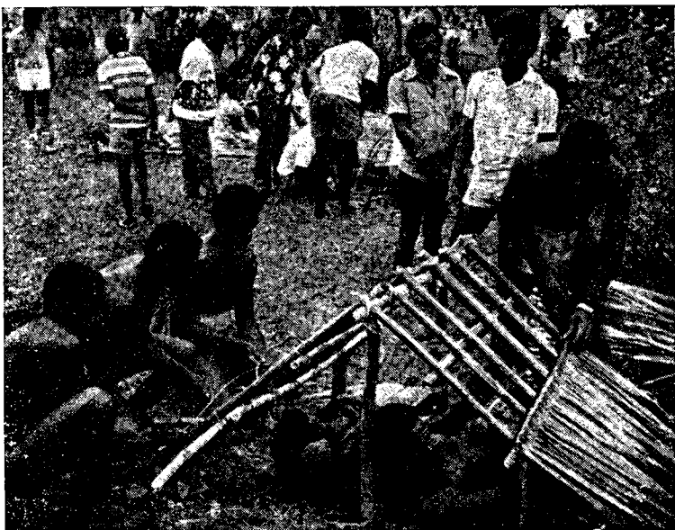
Рис. 4. Способ покрытия хижин пальмовыми листьями
