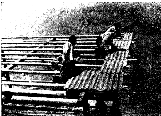
Рис. 9. Строительство скотного двора (устройство крыши). Сел. Кальма
