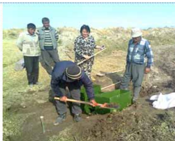
Фото 2 - Процесс установки гидропостов
