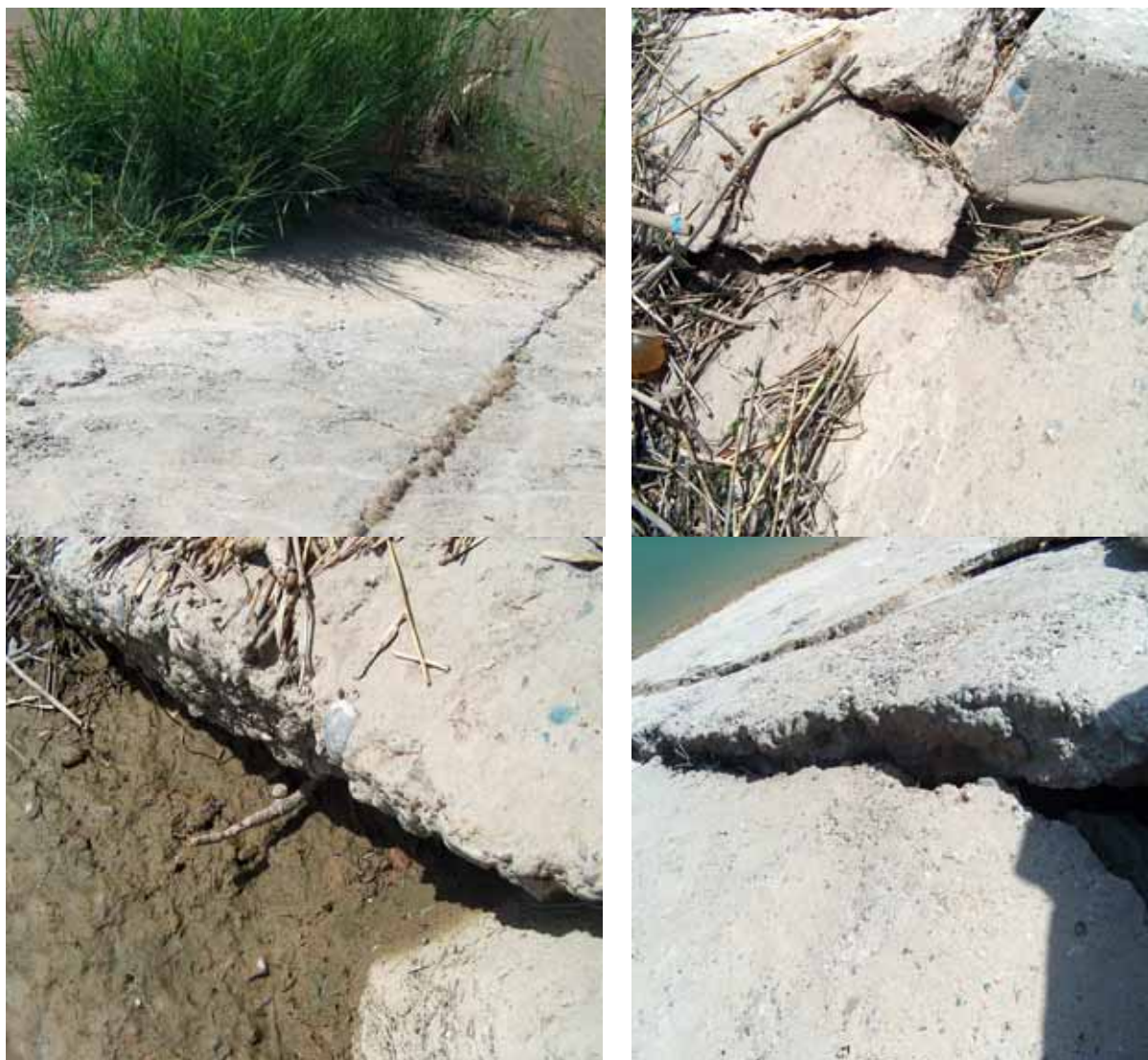
1 расм - Бетон ва темир бетон чокларидаги ёрилиш ва силжишлар
