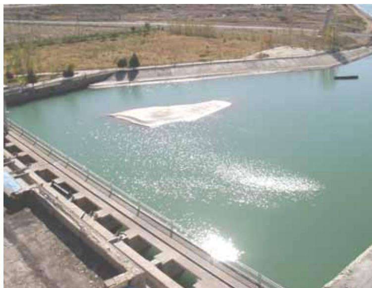
Рис.1 Аванкамера насосной станции № 7 КМК
