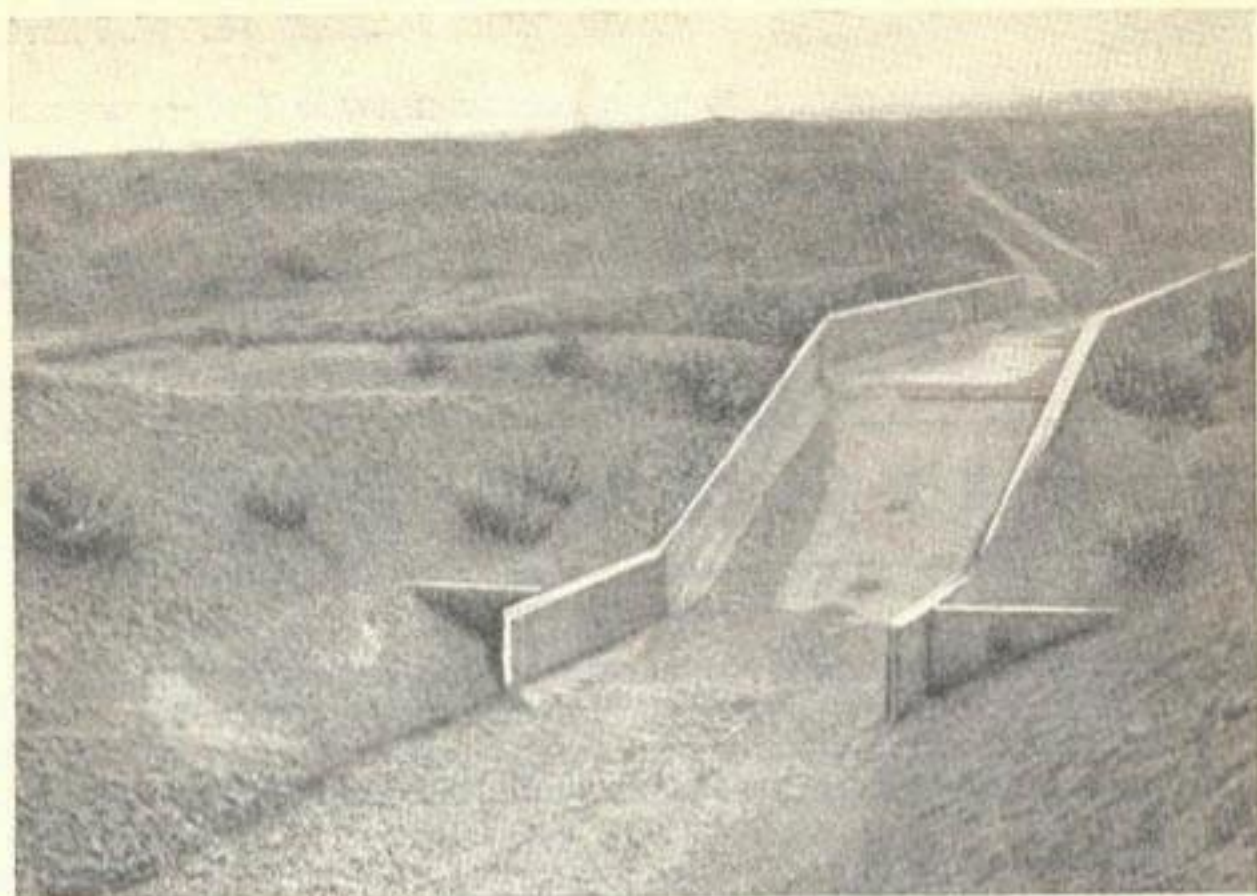
Рис. 26. Лотковое ливнепроточное сооружение на Большом Ферганском канале (вид со стороны нижнего бьефа).
