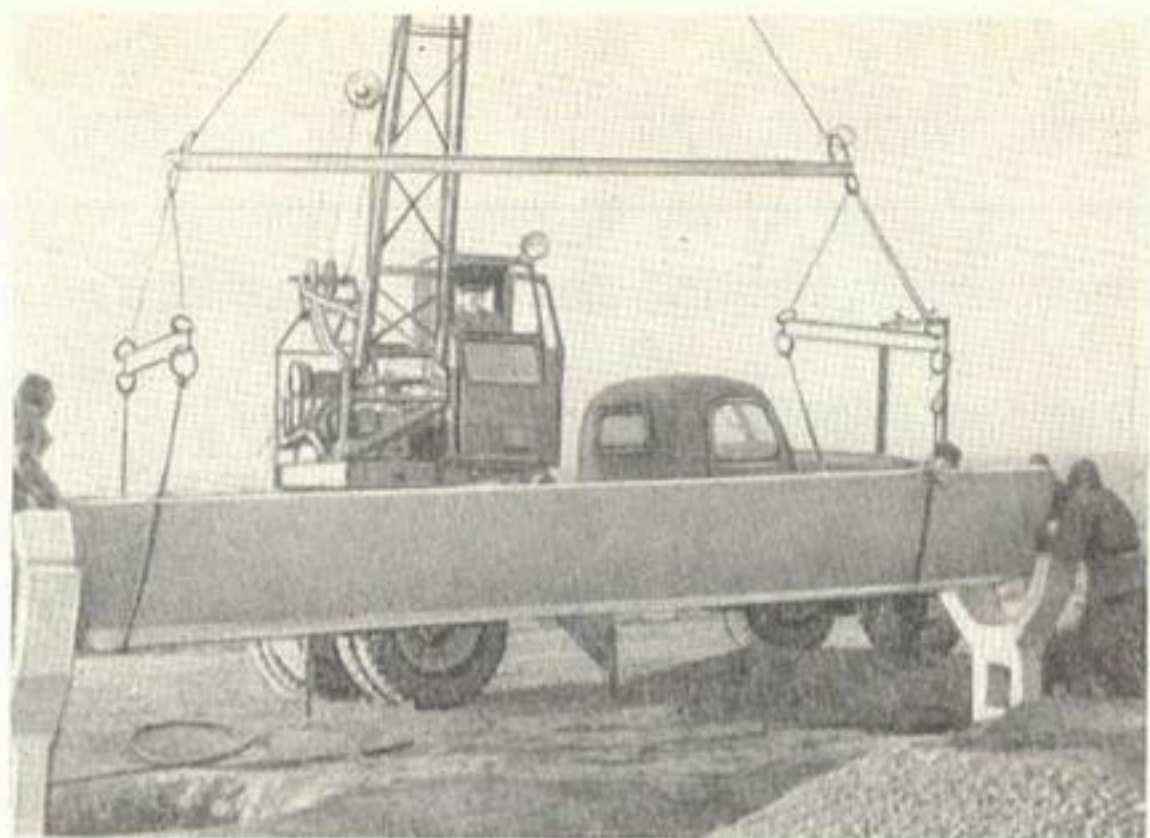
Рис. 128. Укладка лотков на опоры в Голодной степи.
