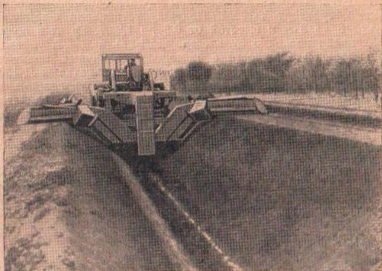
Рис. 7. Экскаватор ЭТР-122 в работе и общий вид проложенного канала.
