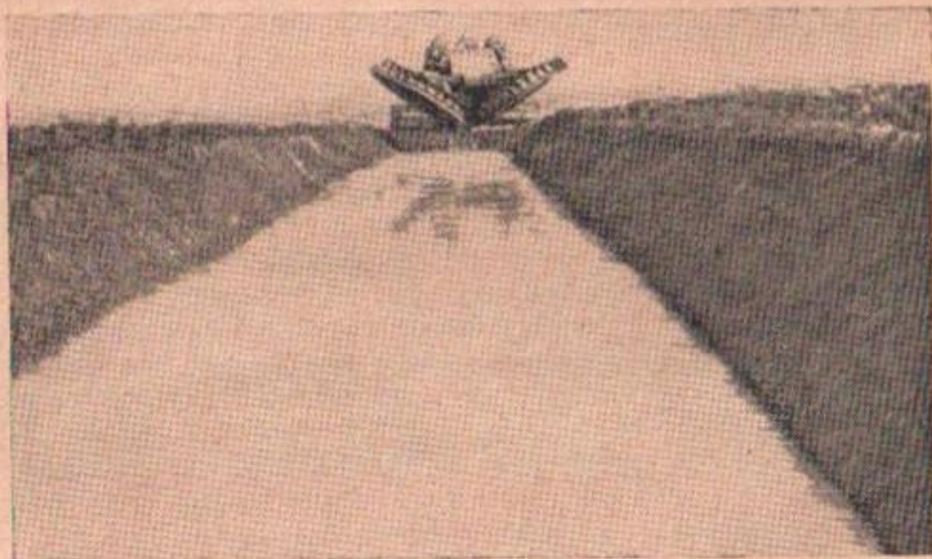
Рис. 14. Машина Д-583 и общий вид канала.
