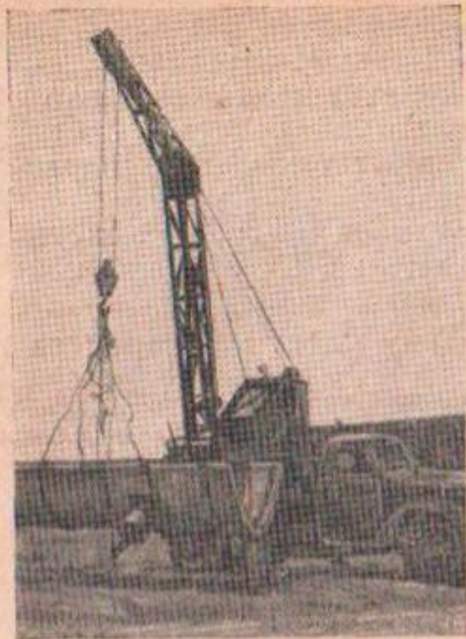
Рис. 54. Монтаж раструбных лотков в совхозе № 10 Голодной степи с помощью автокранов.
