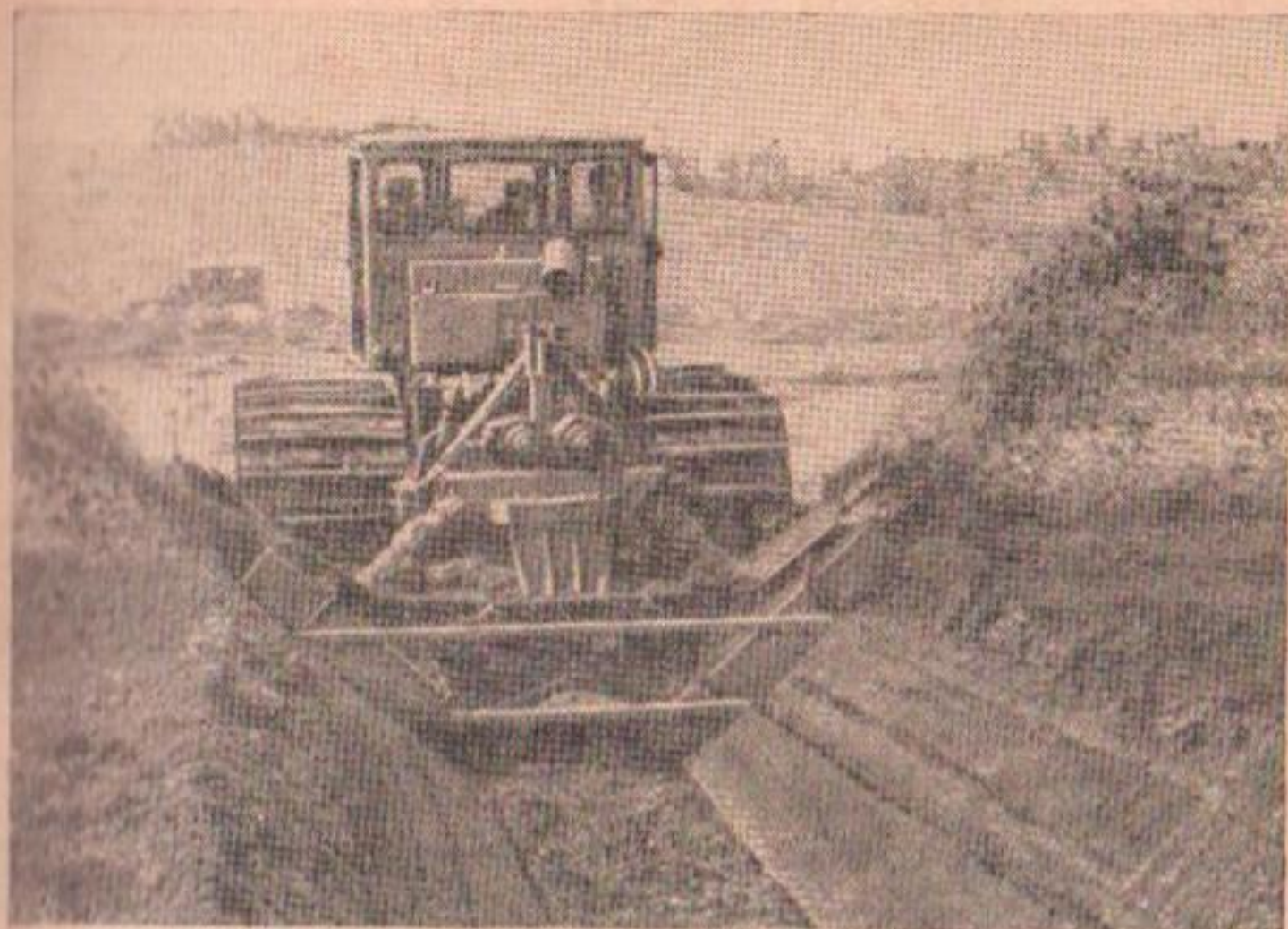
Рис. 8. Фрезерный канавокопатель КФН-1200 в работе.
