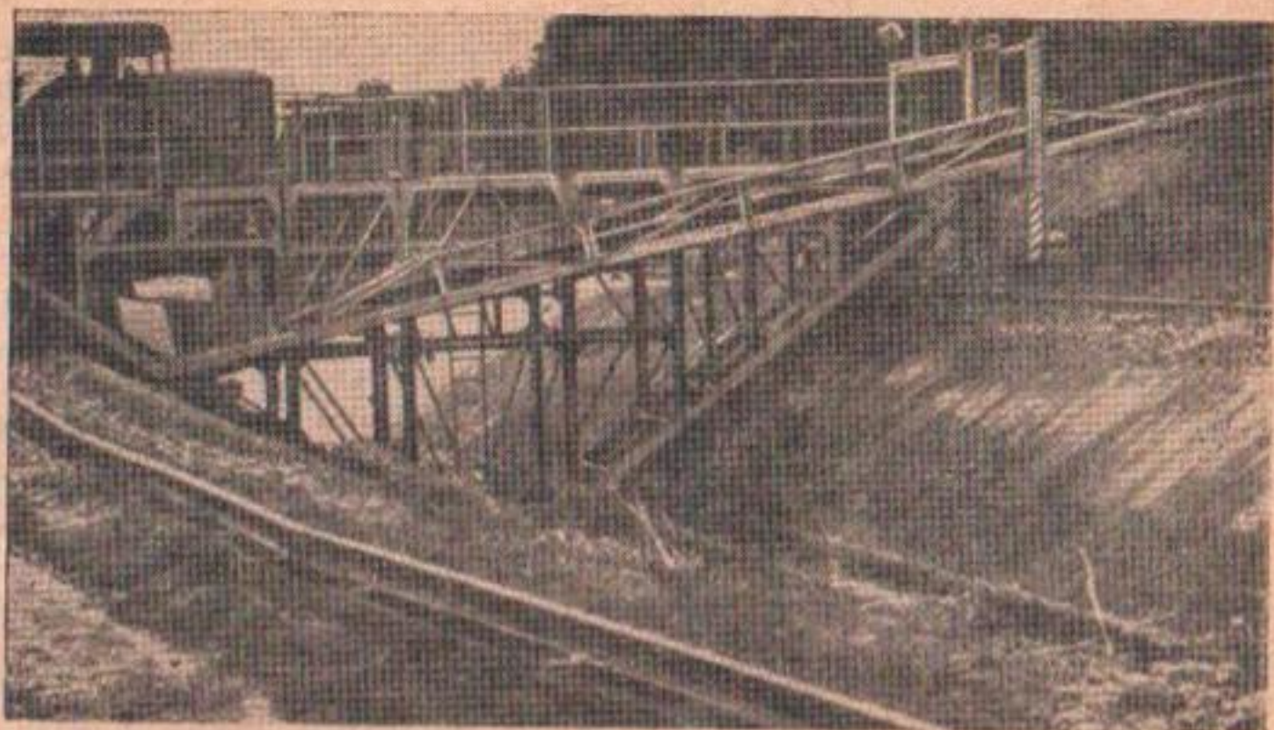
Рис. 55. Экскаватор-профилировщик Д-654.
