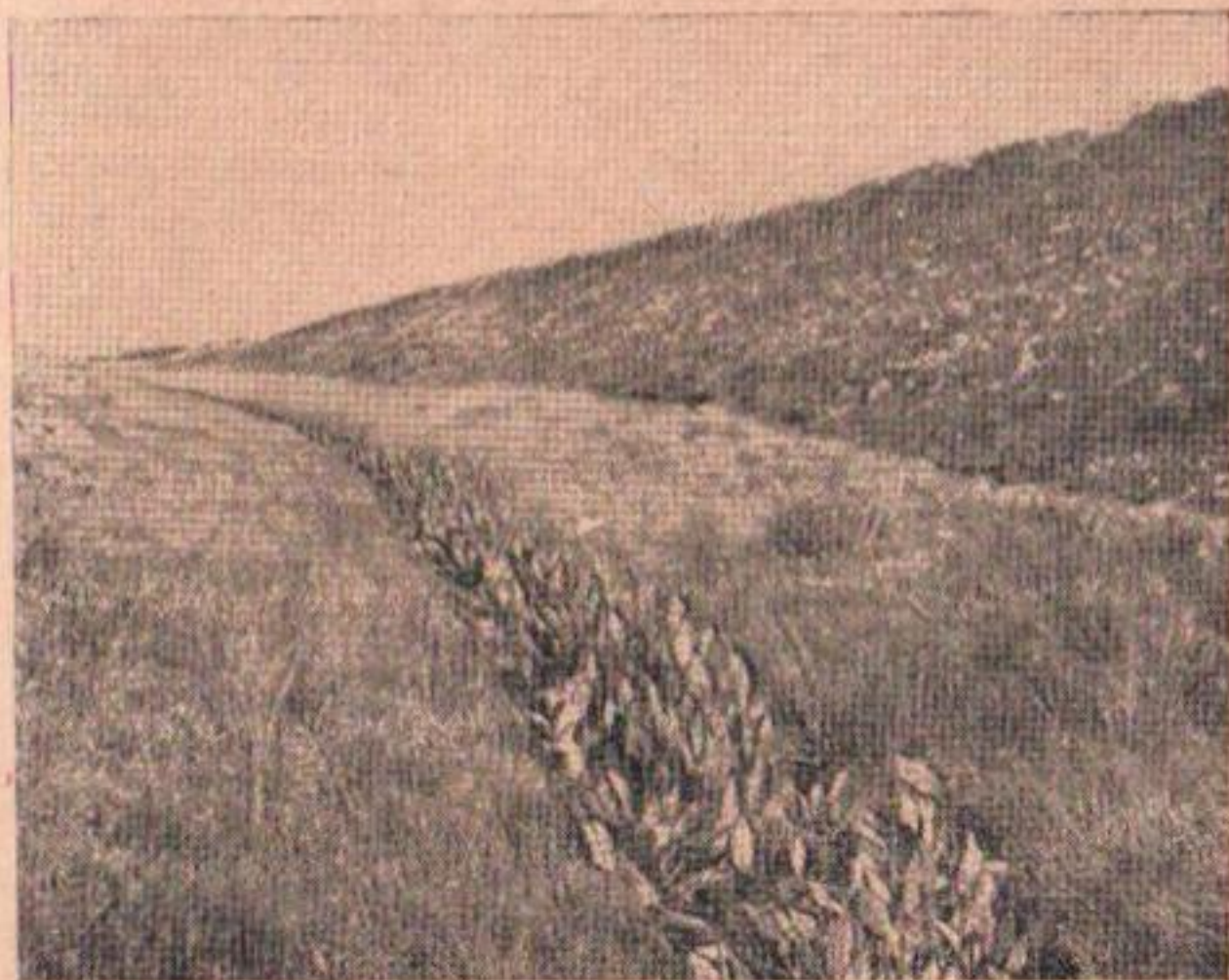
Рис. 15. Заращение дна осушительного канала с одернованными и укрепленными откосами в Литовской ССР.
