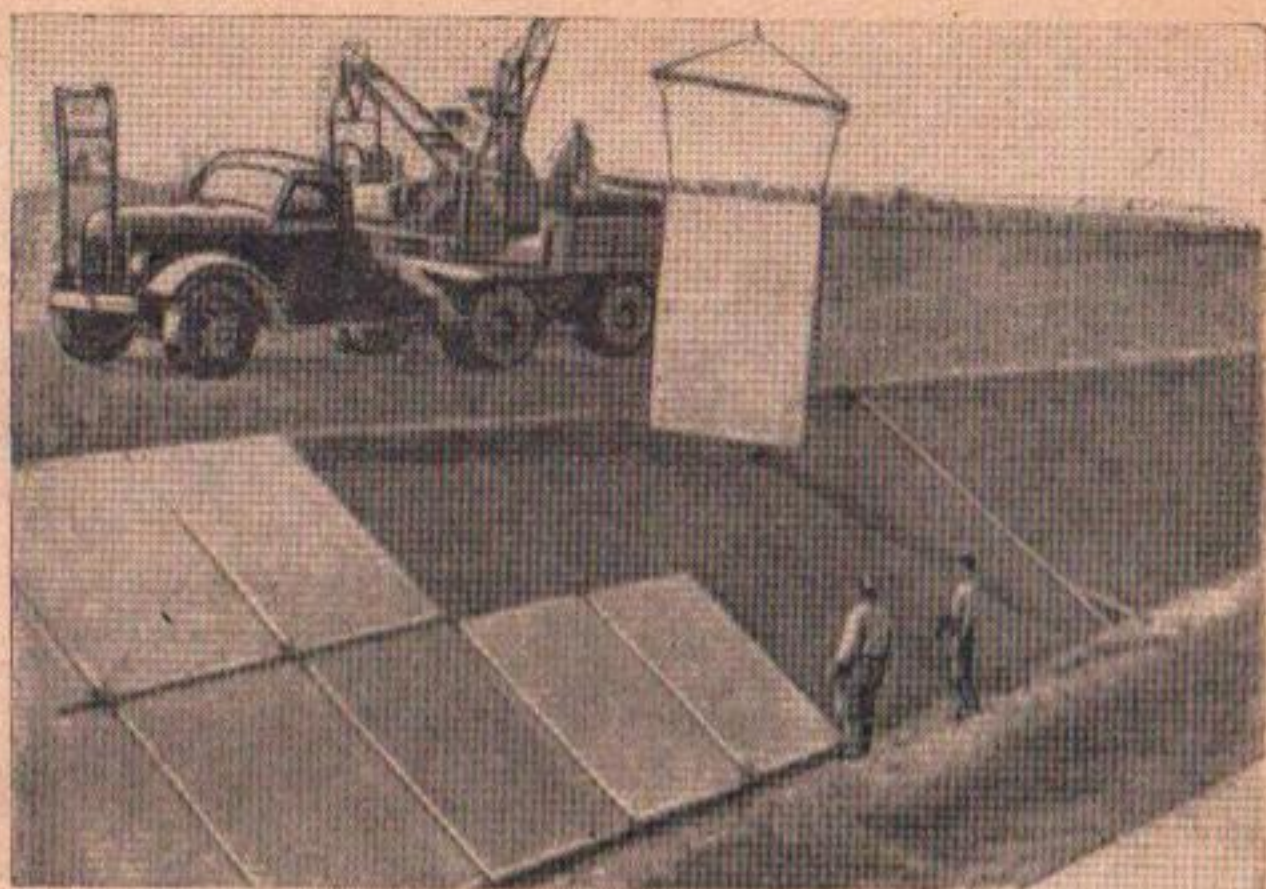
Рис. 53. Укладка плит автокраном.
