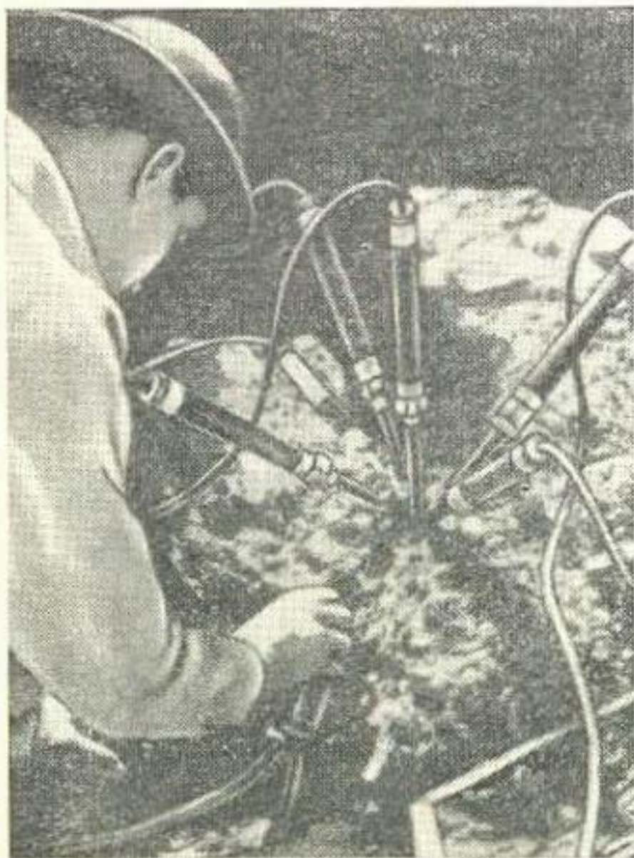
Рис. 50. Плотина Шаста. Монтаж тензометра
