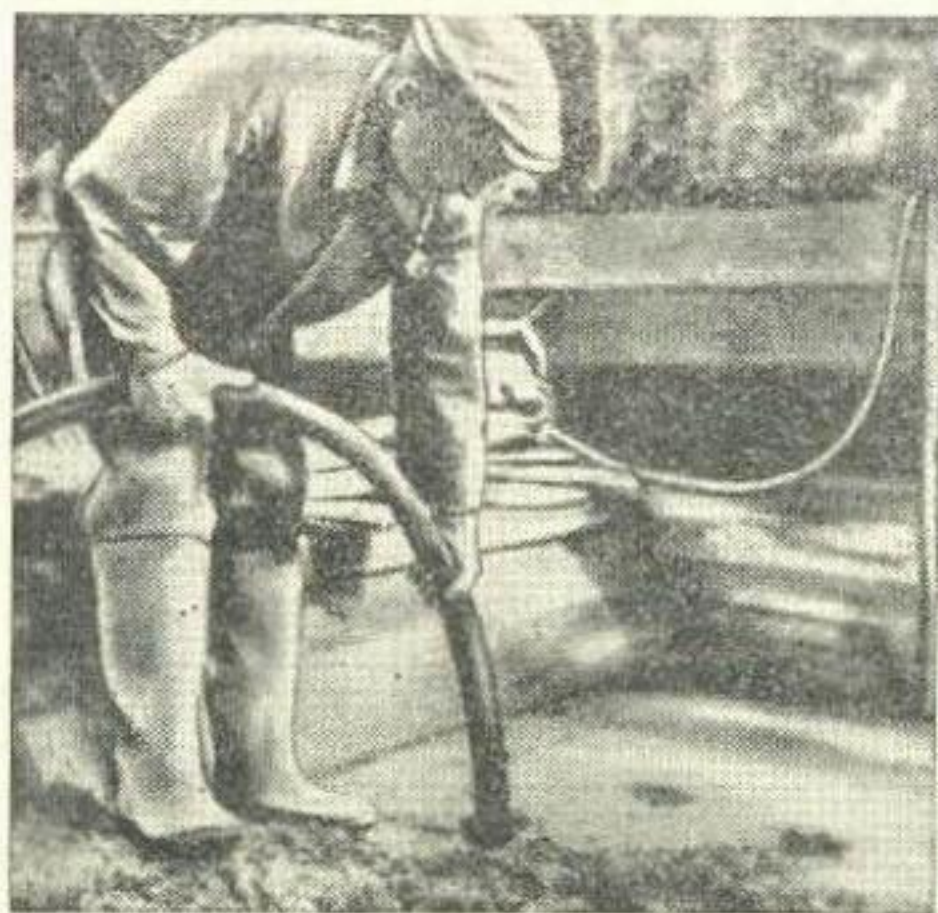
Рис. 13. Вибрирование бетона высокочастотным вибратором
