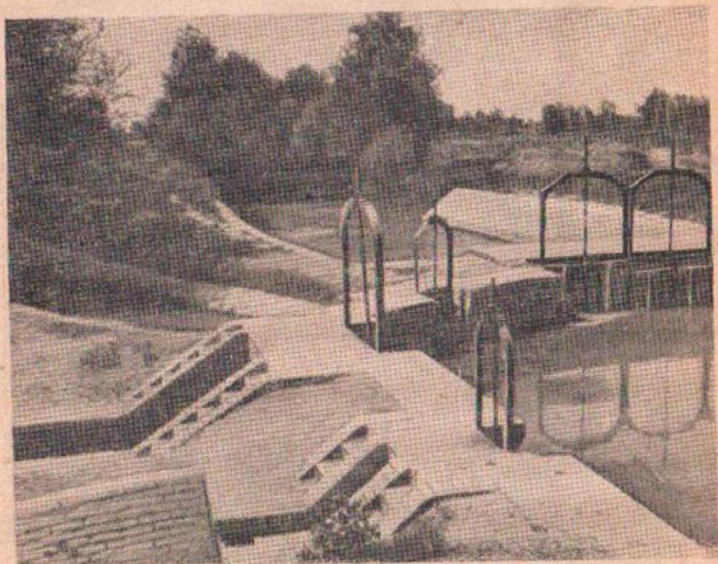
Рис. 8. Бетонное вододелительное сооружение.
