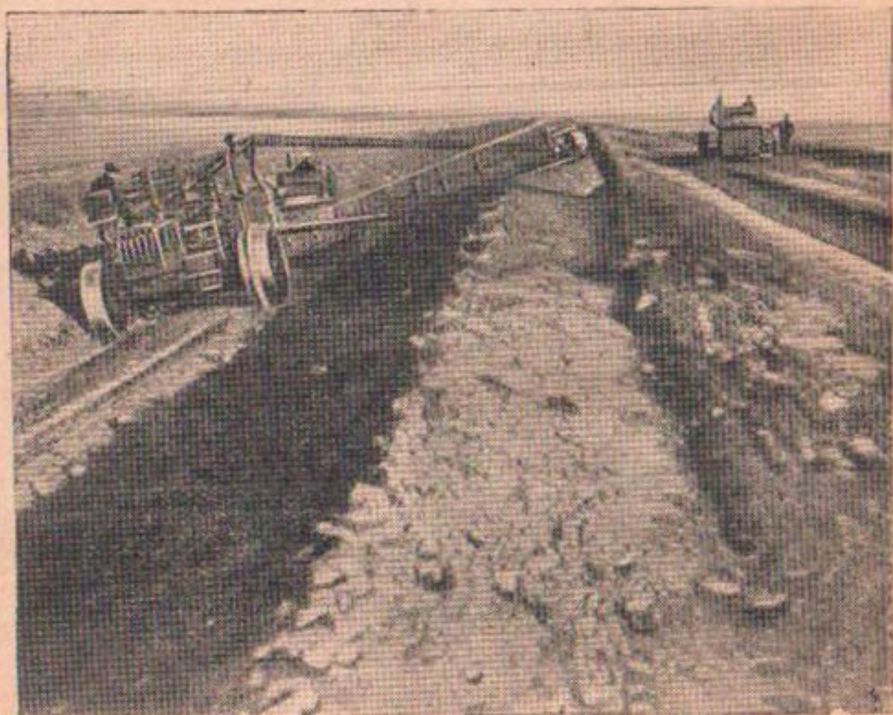
Рис. 42. Грейдер-элеватор на постройке крупного канала.
