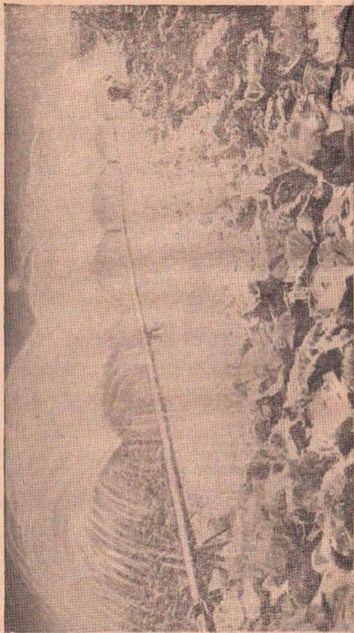
Рис. 29. Короткоструйная дождевальная установка на поливе овощей.
