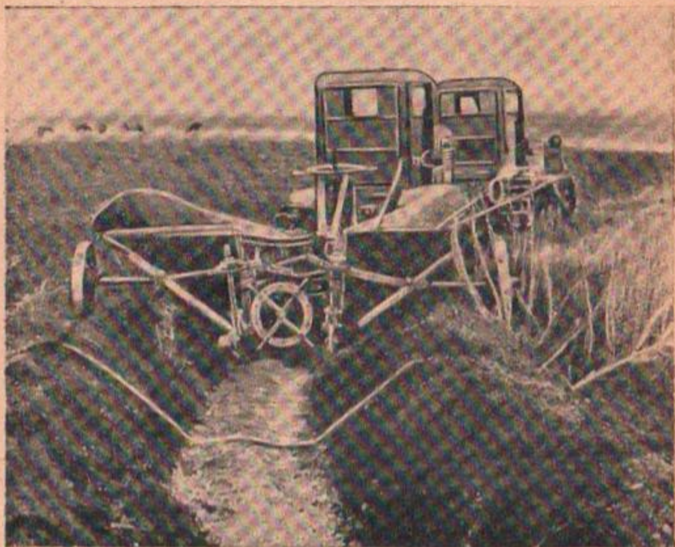
Рис. 40. Плужный канавокопатель на постройке канала.
