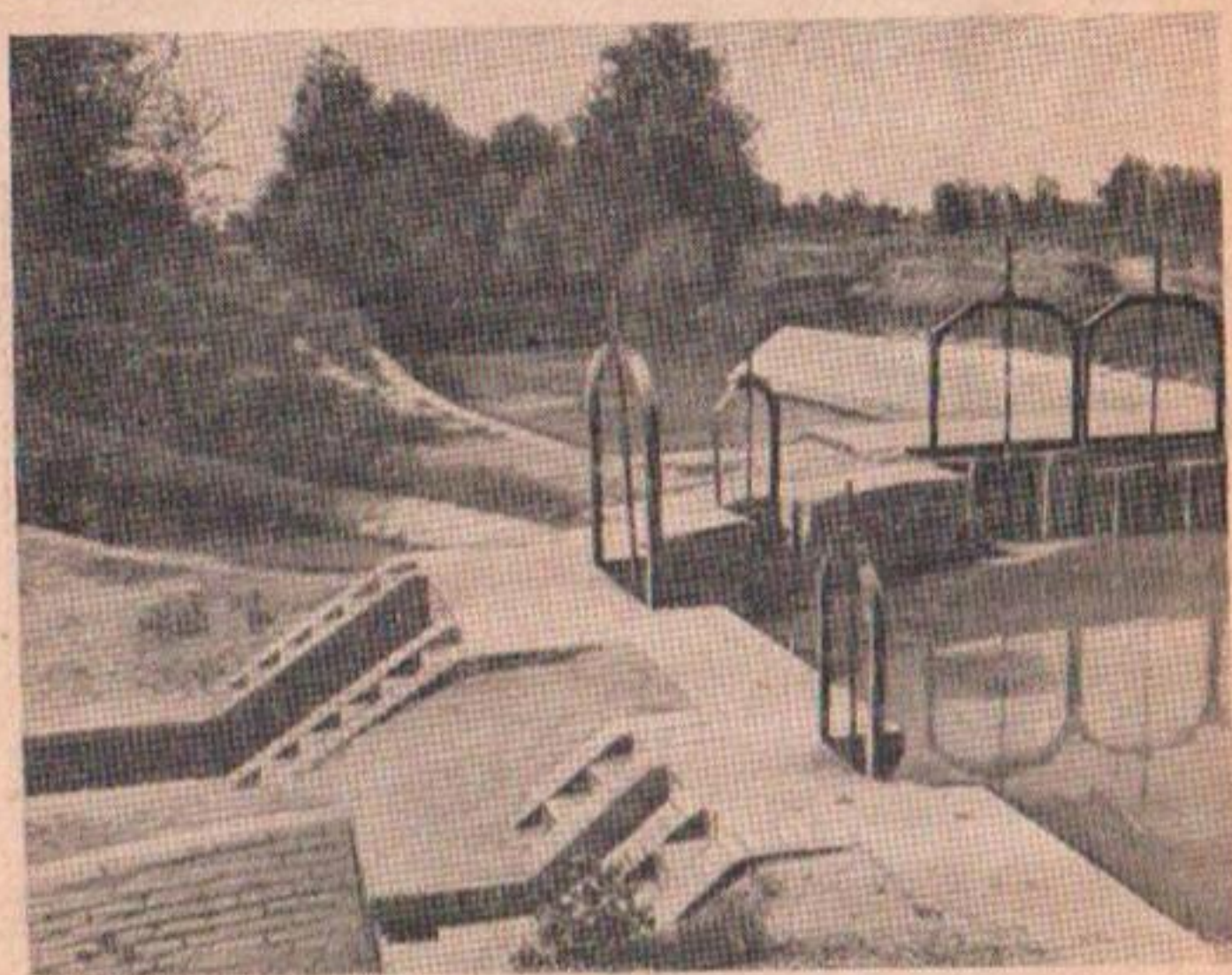
Рис. 8. Бетонное вододелительное сооружение.
