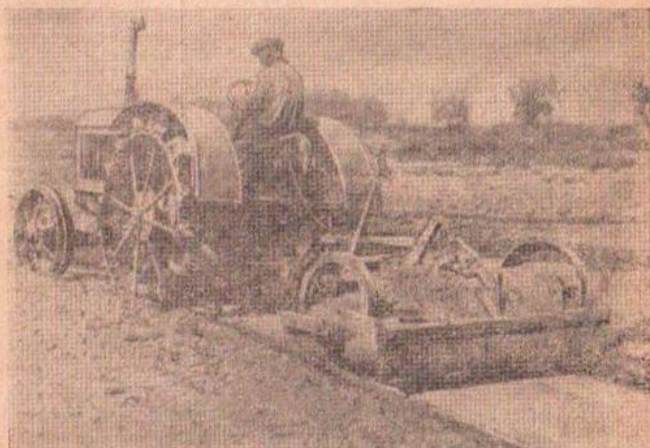
Рис. 39. Ползунковый скрепер в работе.
