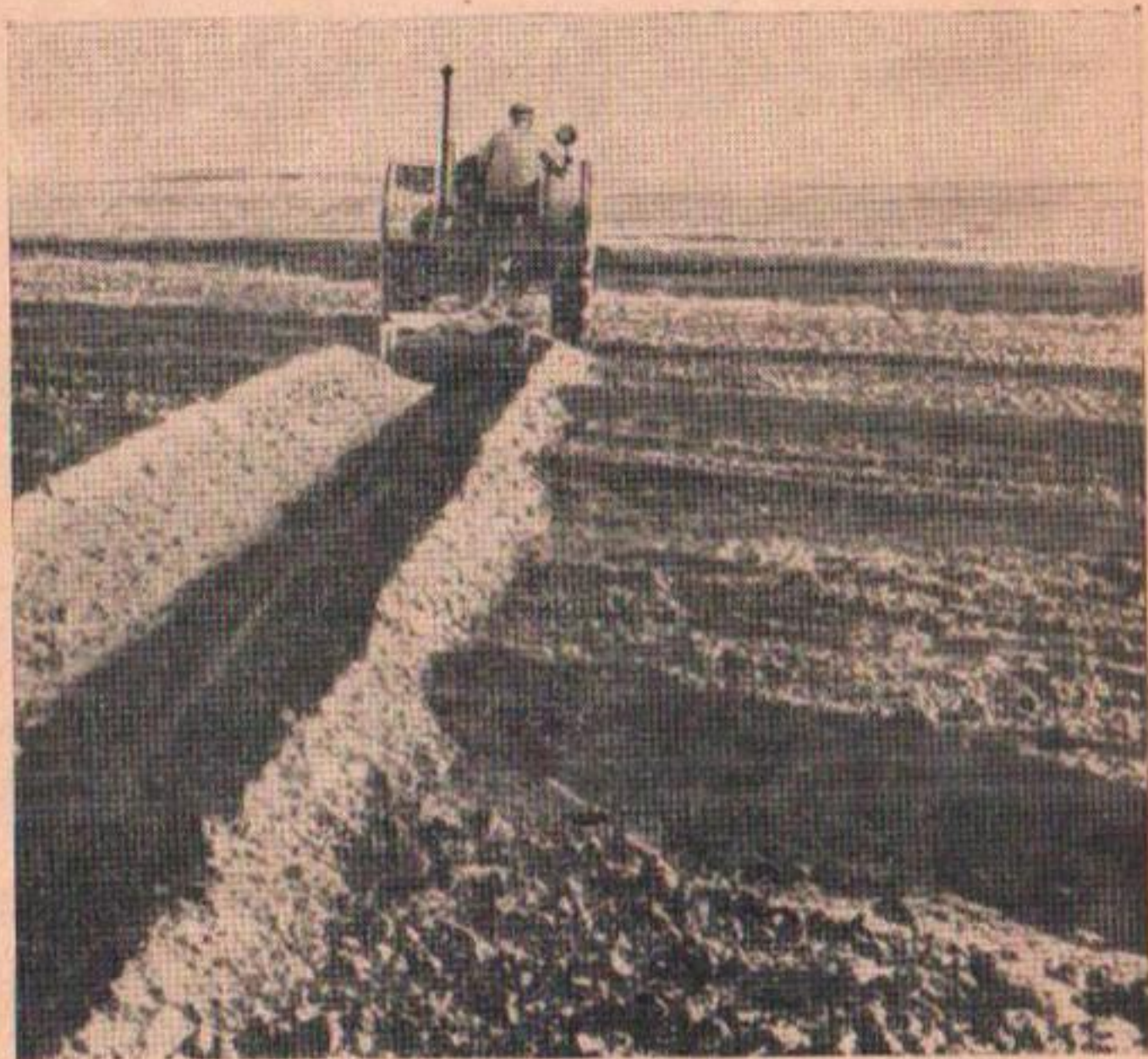
Рис. 48. Канавокопатель нарезает выводную канаву.
