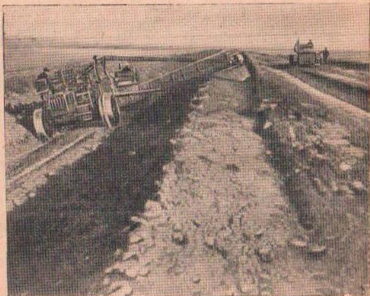
Рис. 42. Грейдер-элеватор на постройке крупного канала.
