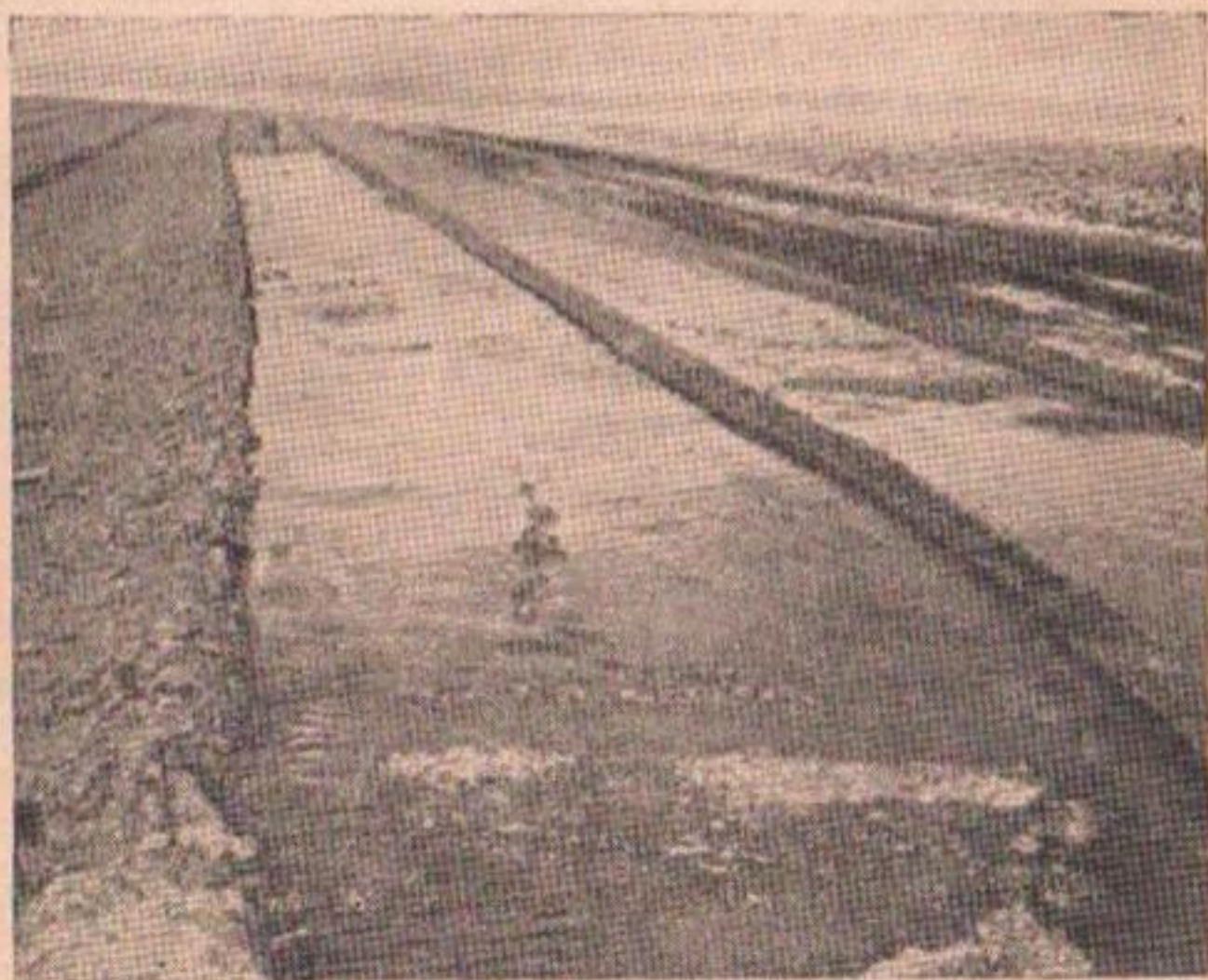
Рис. 21. Полив напуском по полосам.
