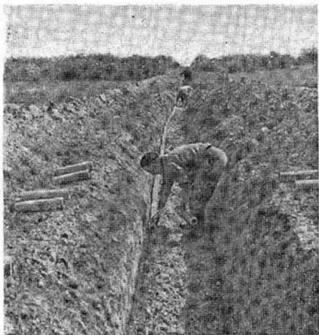
Укладка гончарного дренажа.
