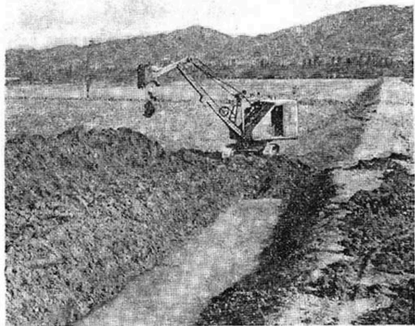
Строительство осушительного канала в Колхидской низменности.
