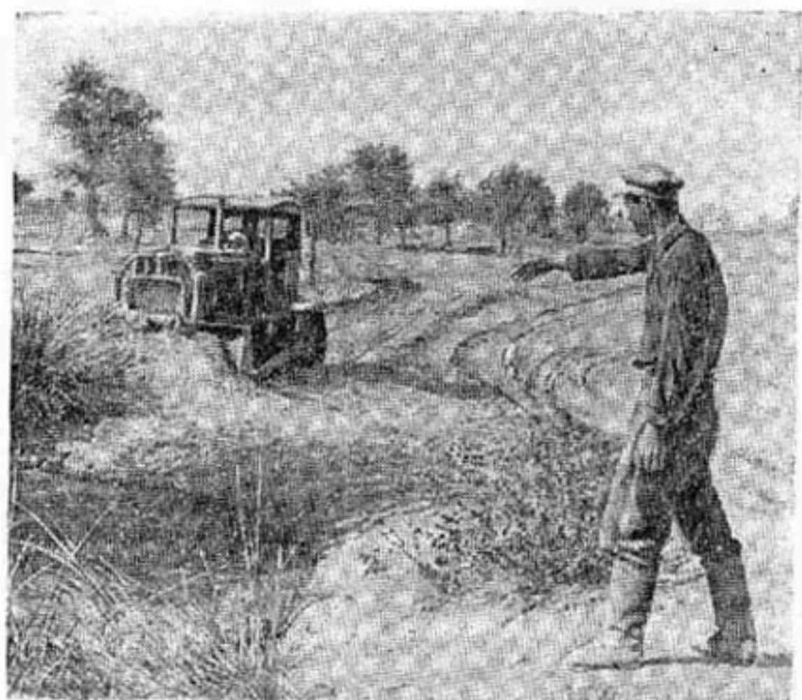
Бульдозер Д-159Б на планировке.
