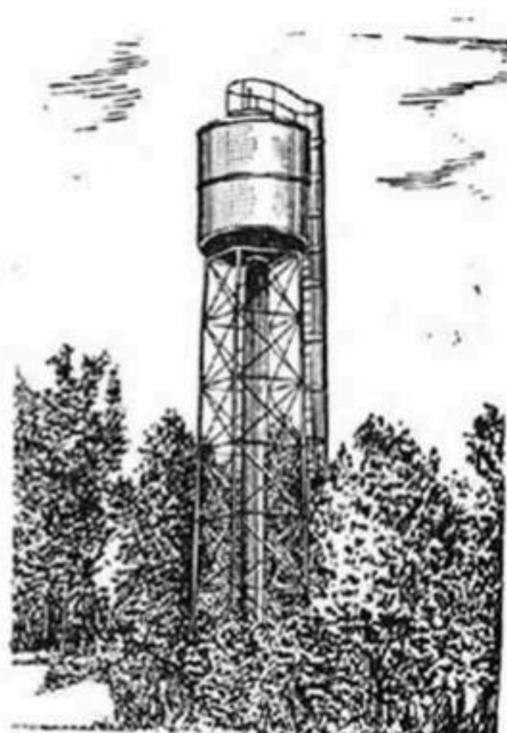
Водонапорная башня конструкции «Стройводшесематика».
