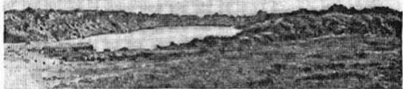
Копань в Новочеркасском совхозе Акмолинской области, устроенная взрывным способом.
