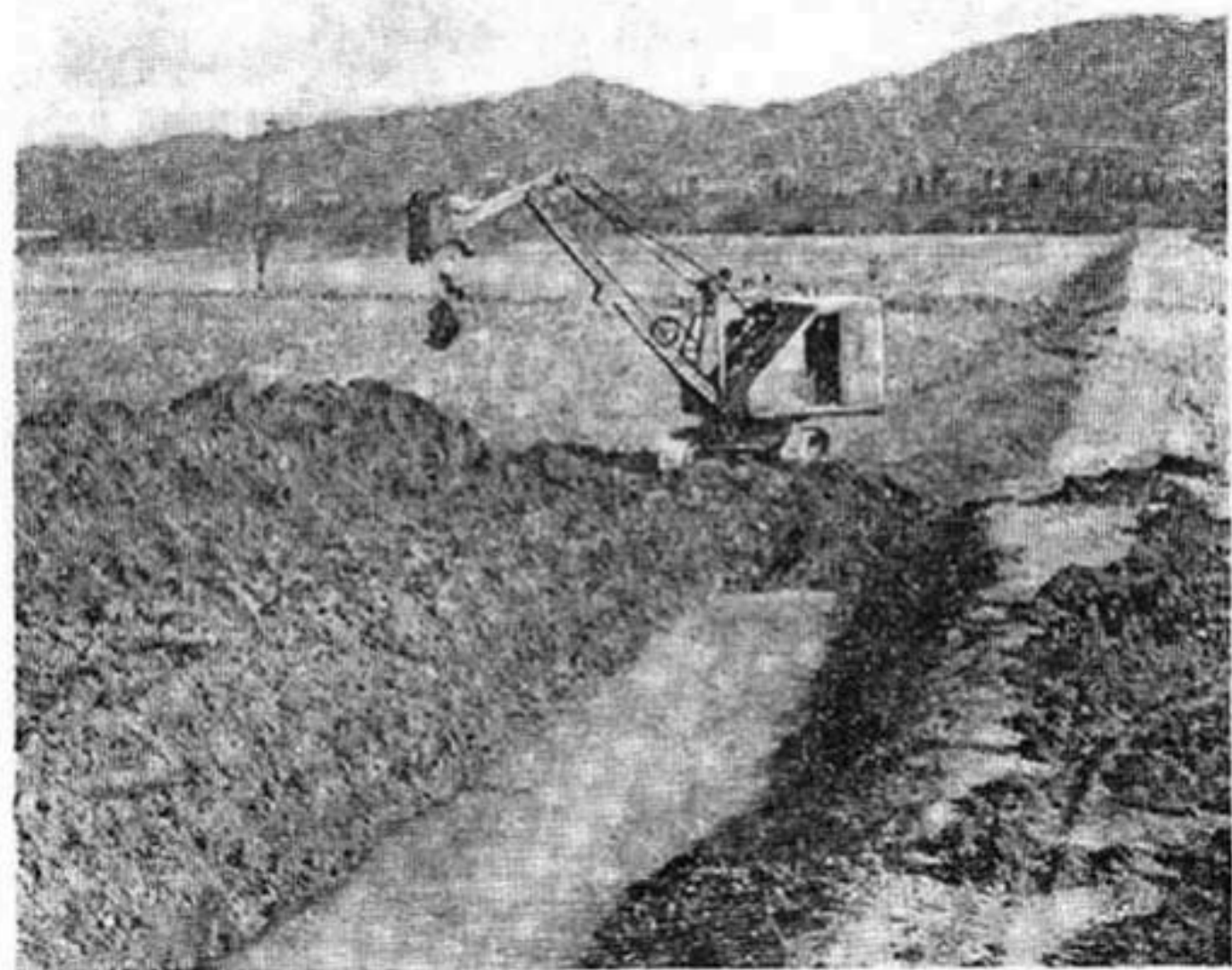
Строительство осушительного канала в Колхидской низменности.
