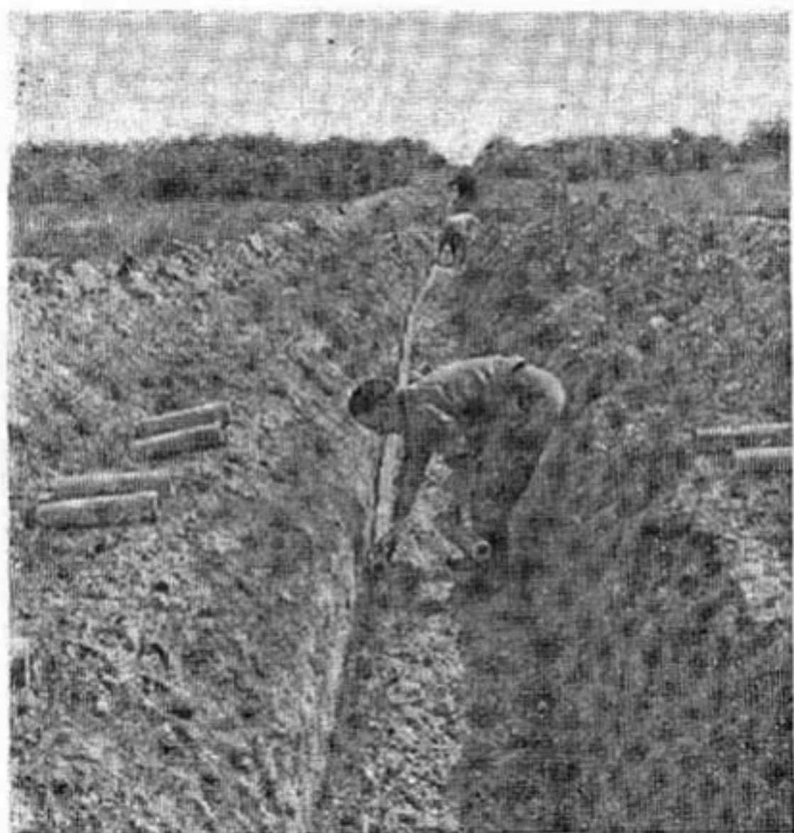
Укладка гончарного дренажа.
