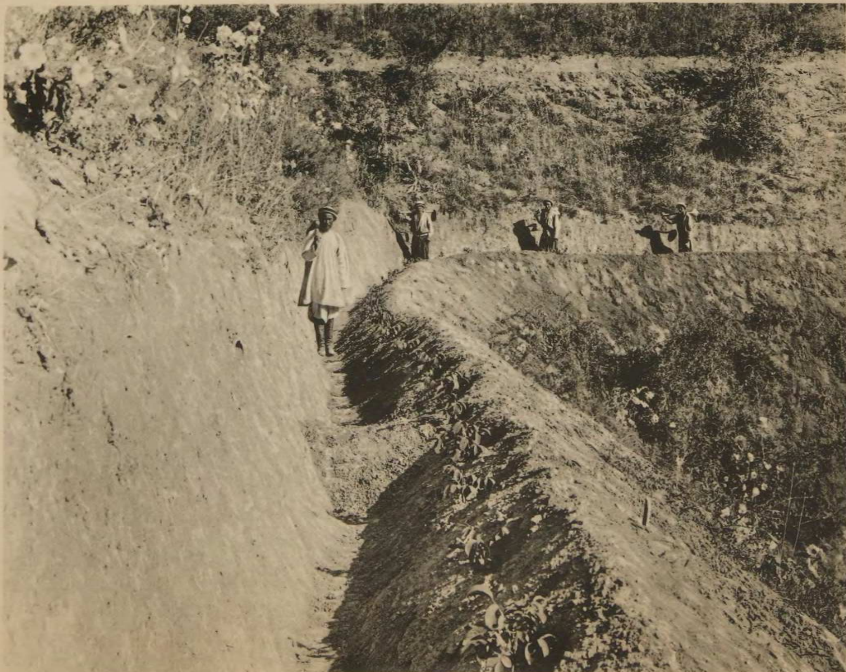
Терраса по горному склону въ 35°. Впереди первого, стоящаго въ канавѣ террасы рабочаго, видна перемычка террасы и видны посаженные по валу террасы 1-лѣтніе саженцы грецкаго орѣха.
