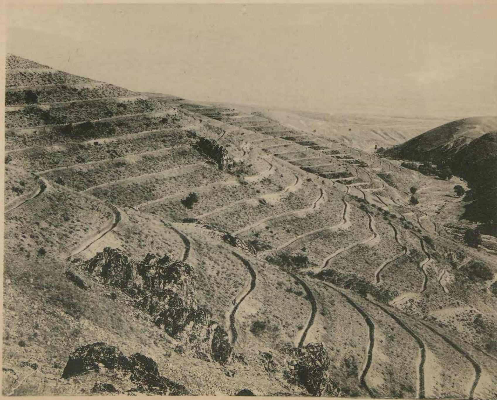
Террасировка горныхъ склоновъ въ 15-25° при разстояніи между террасами, по перпендикуляру, въ 3 саж. Видъ на террасы сверху.
