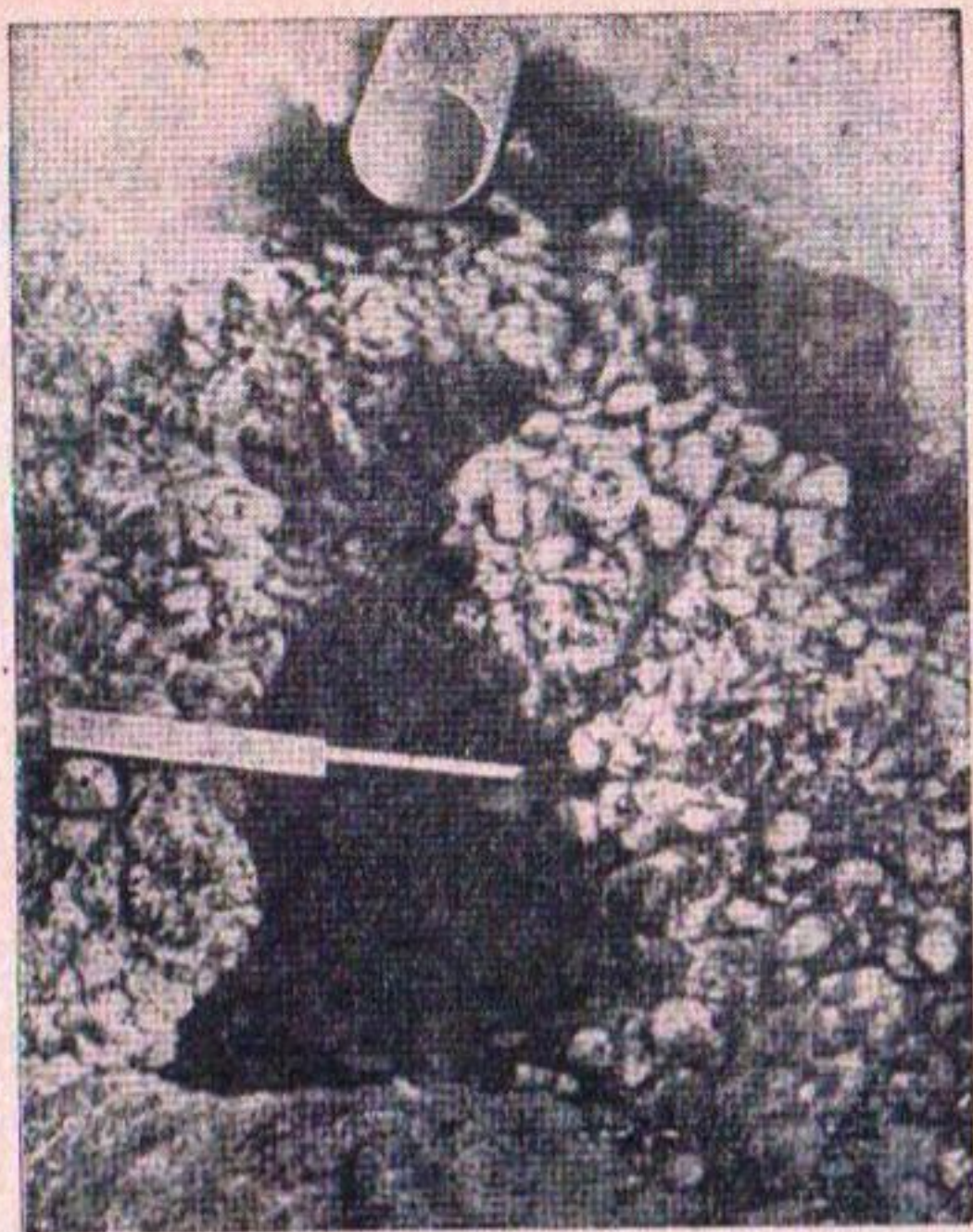
Рис. 2. Общий вид размыва в нижнем бьефе.
