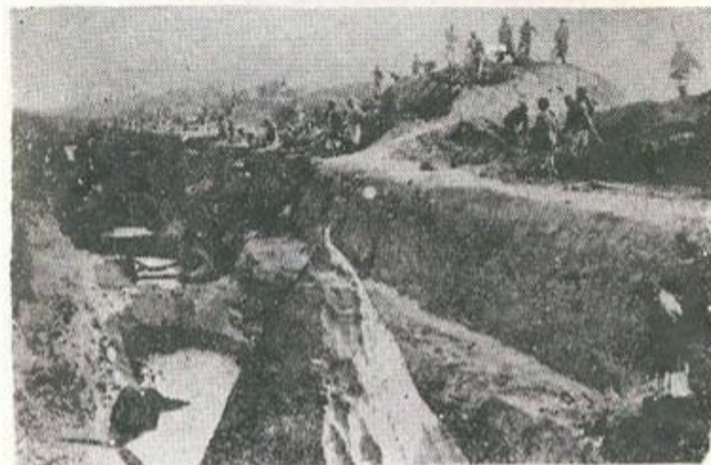
Рис. 1. Строительство канала вручную.
