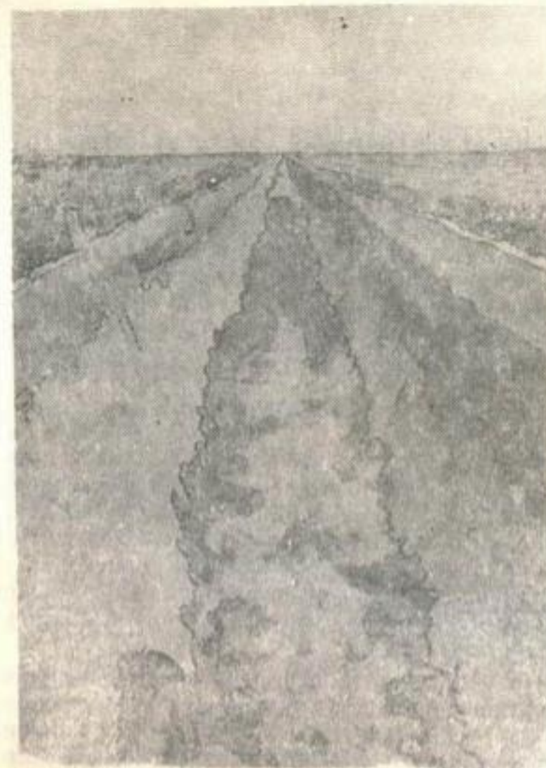
Рис. 3. Заиление лотков-каналов.
