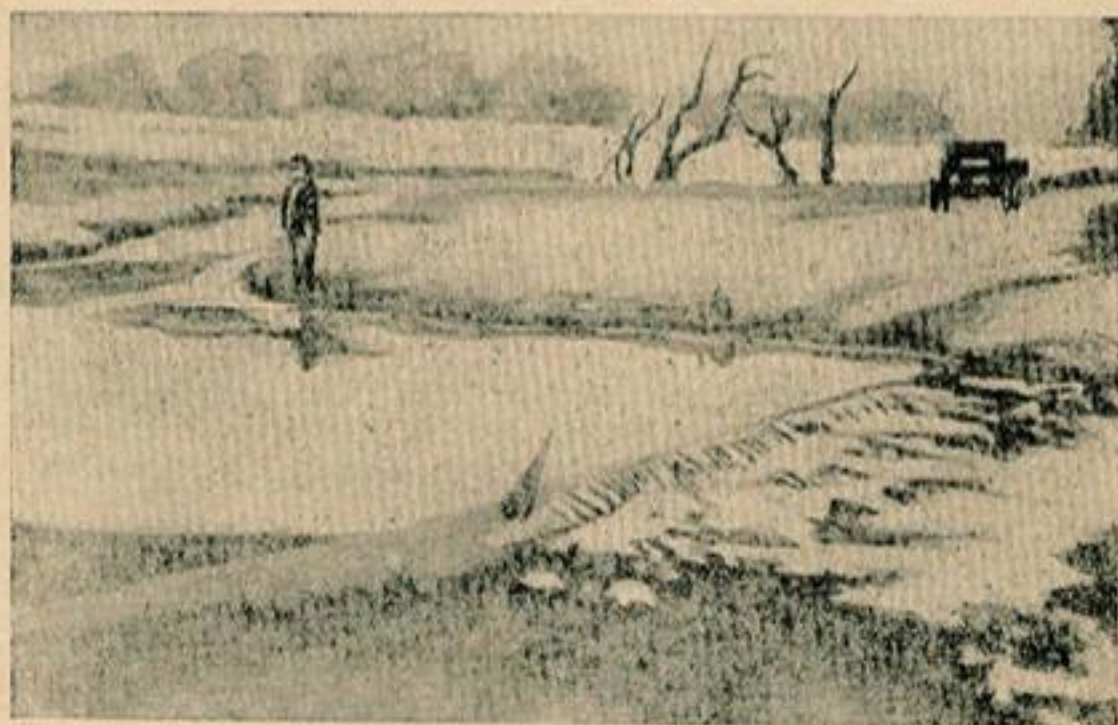
Фиг. 16. Порог-регулятор.
