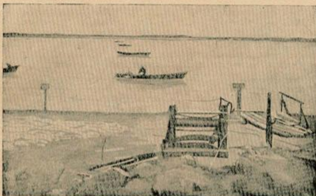
Фиг. 7. Промеры по тросу при широкой реке.
