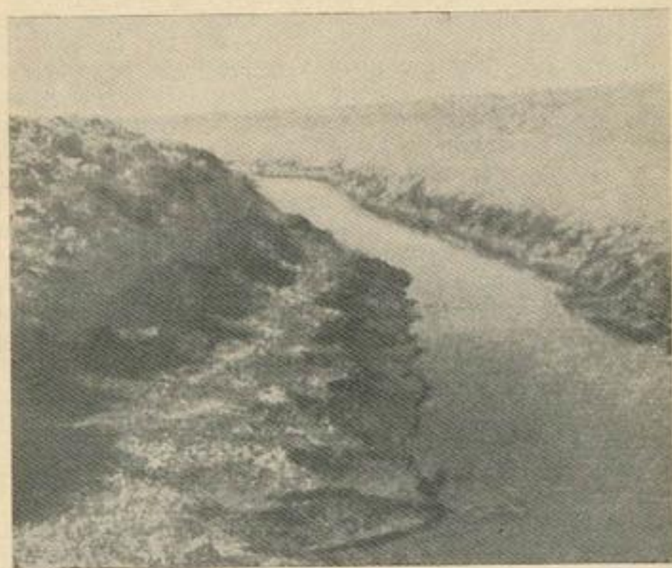
Рис. 18. Открытая глубокая дрена в Мургабском оазисе. Почвогрунты оплывают даже при пологих откосах.
