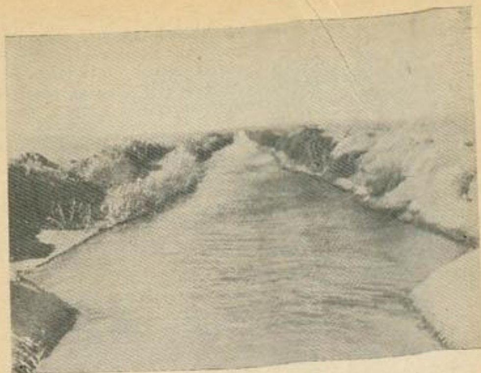
Рис. 22. Канал им. Москвы на опустыненных землях.
