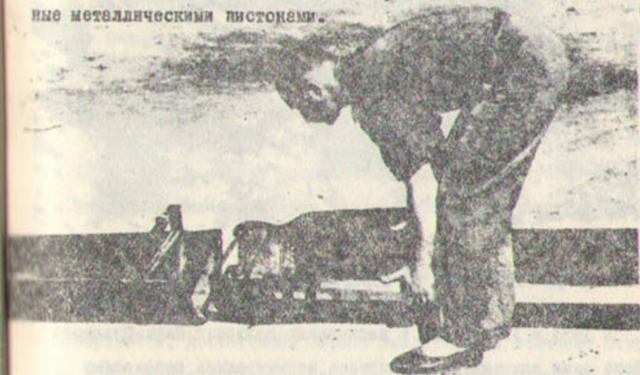
рис. 10. Соединение звеньев брезентового лотка
