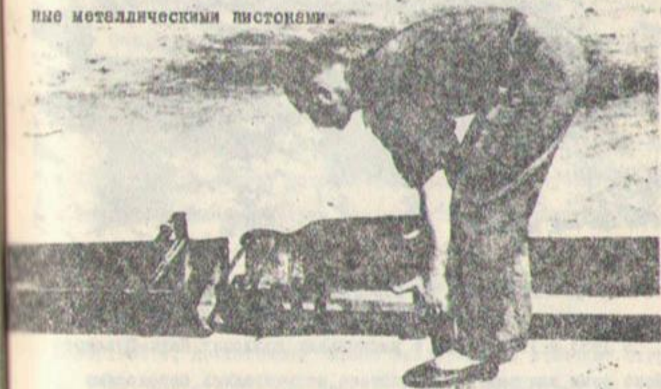
рис.10. Соединение звеньев брезентового лотка
