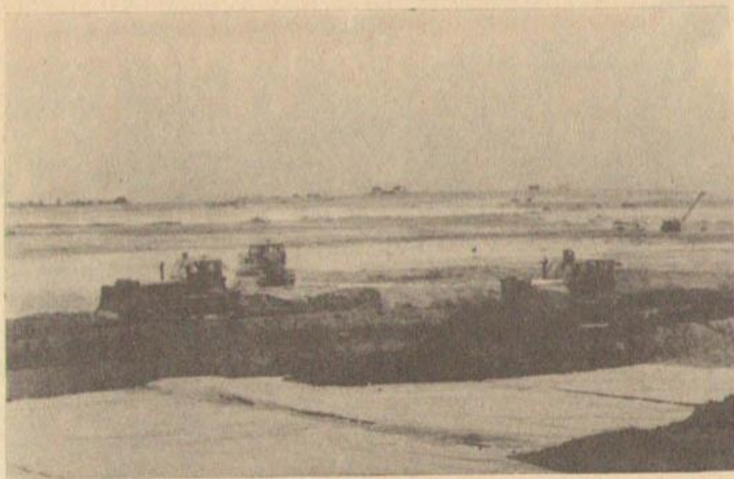
Укладка пленки в чашу Базар-Коргонского водохранилища.
