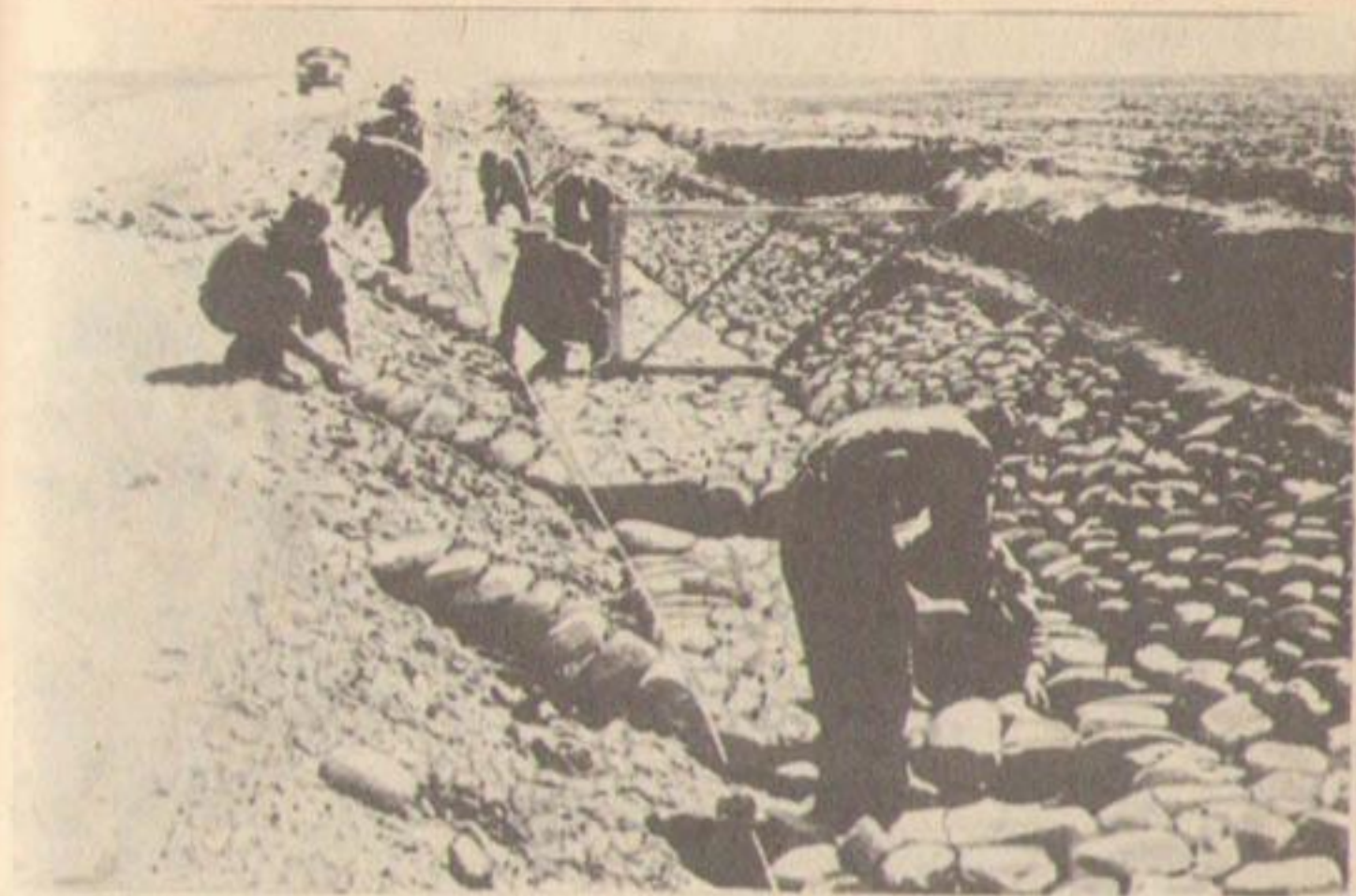
Канал Суусамырский. Процесс мощения.
