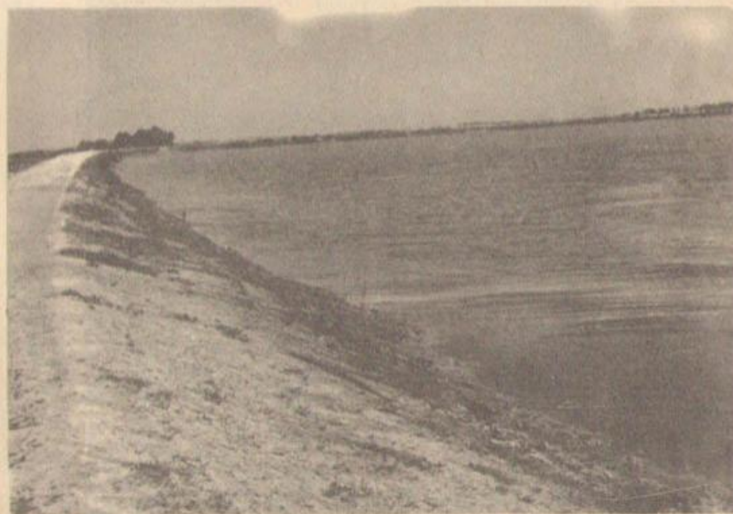
Бассейн суточного регулирования расходов воды
