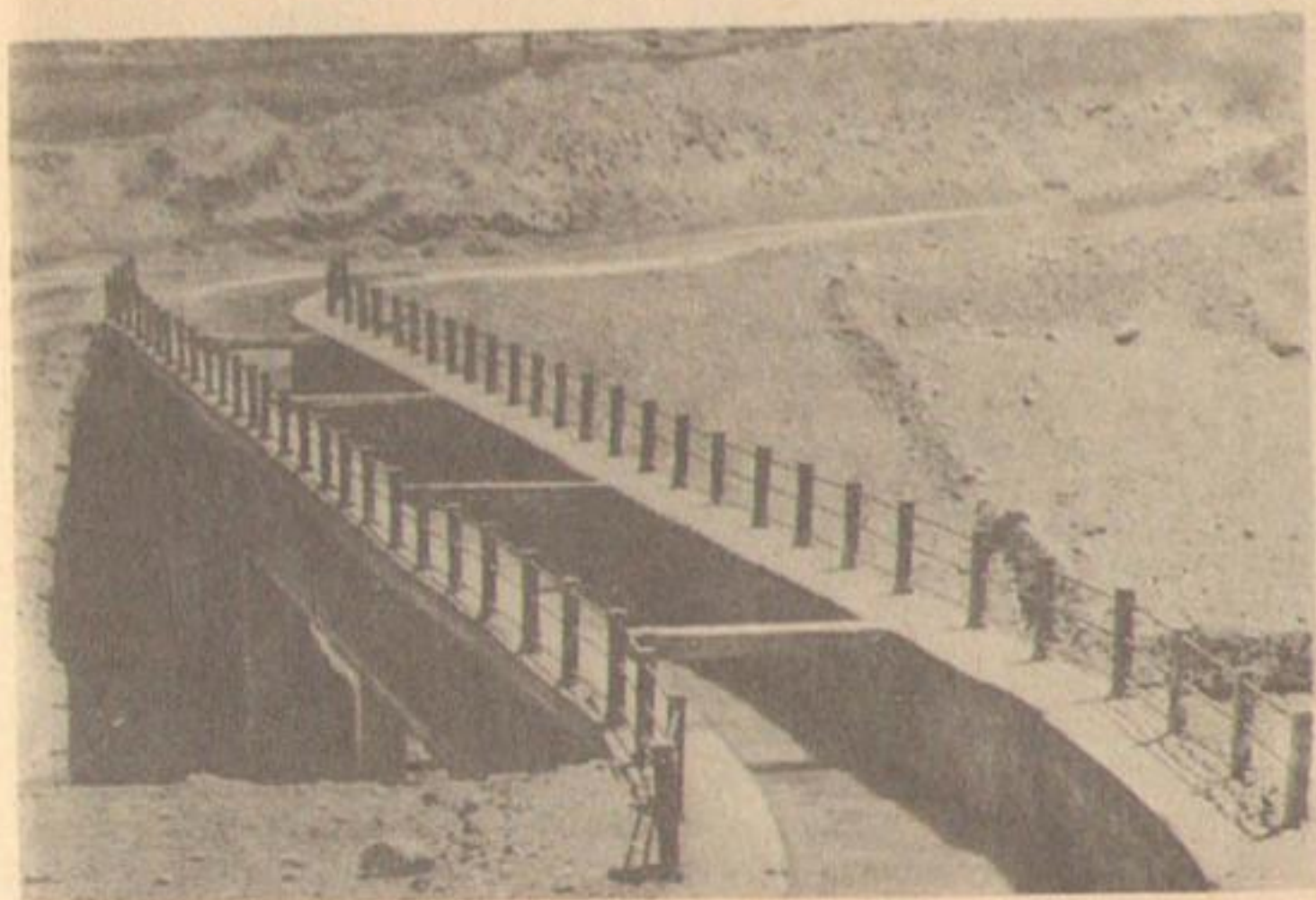
Акведук на канале Найман.
