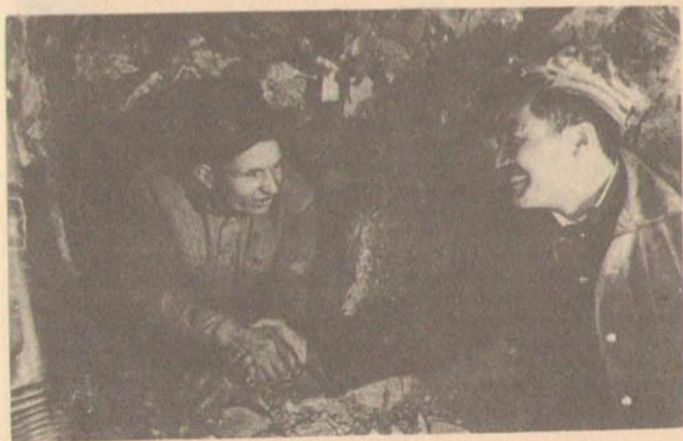
Торжественный момент: сбойка Ортокоюского тоннеля. Проходчики Жиндигов и Молдыбаев.
