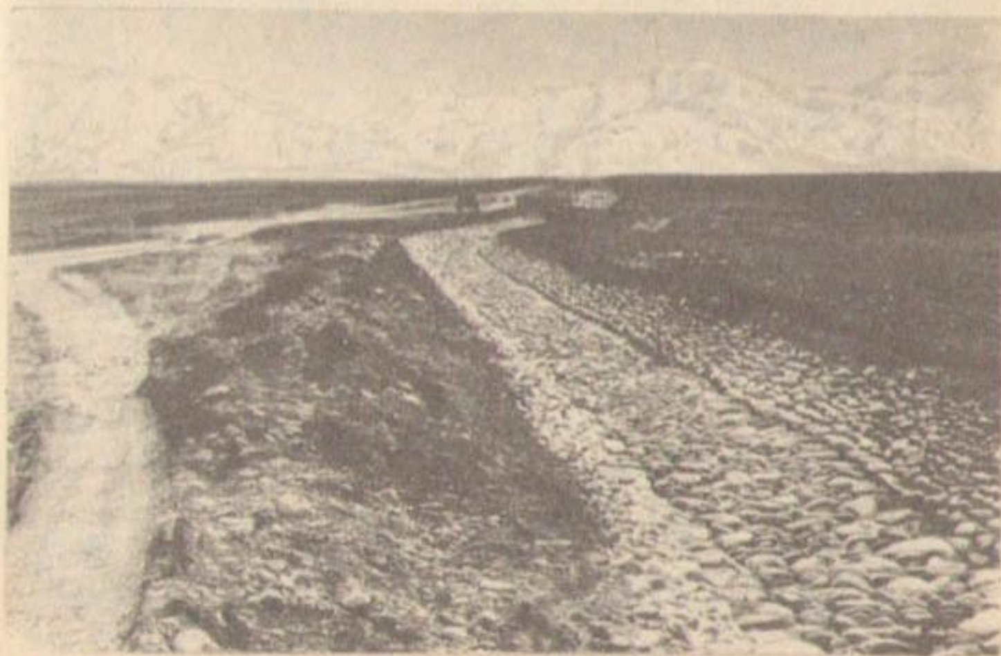
Канал Суусамырский. Переустройство завершено.
