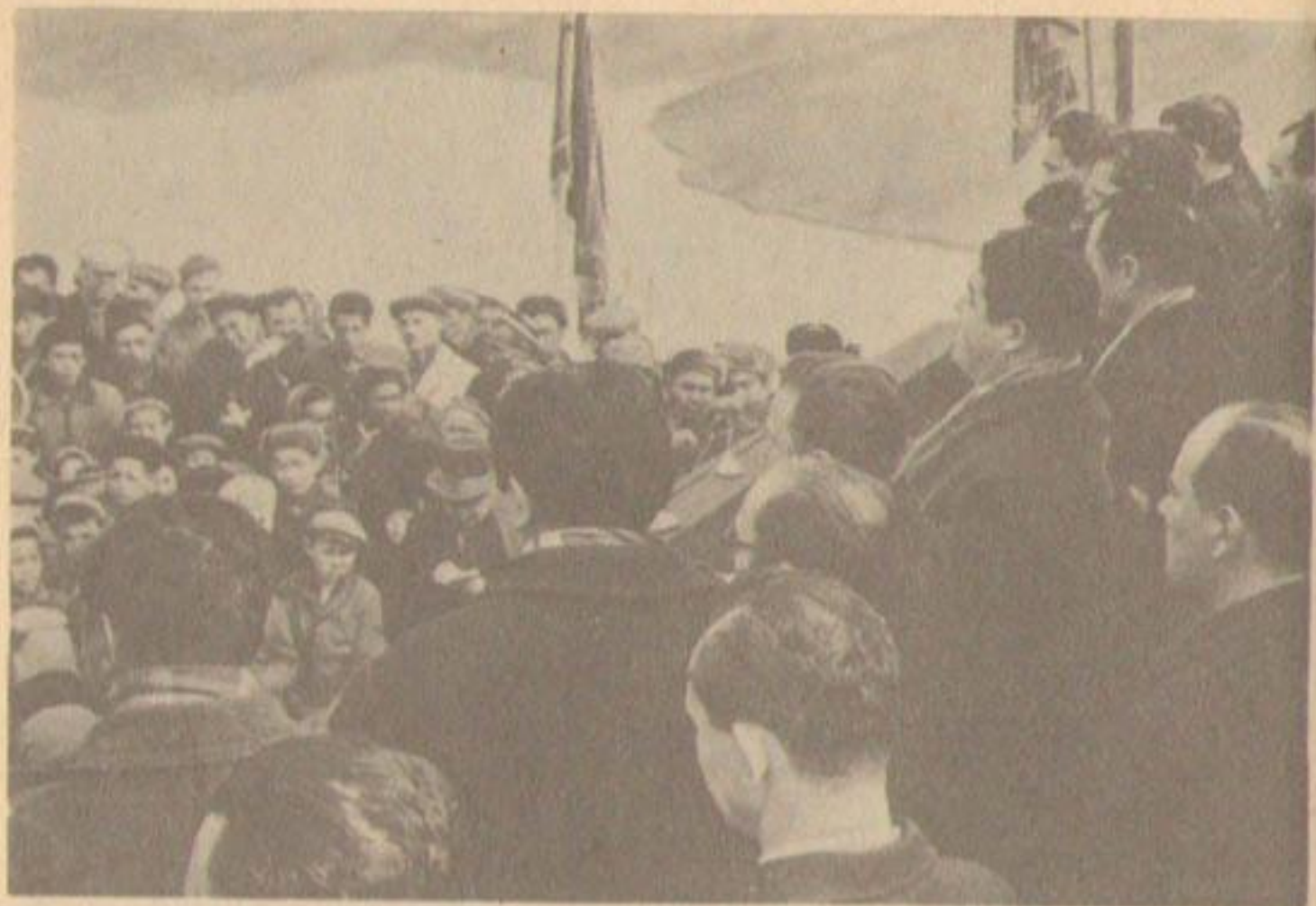
Торжественный митинг по завершению основных работ по сооружению Найманского водохранилища.
