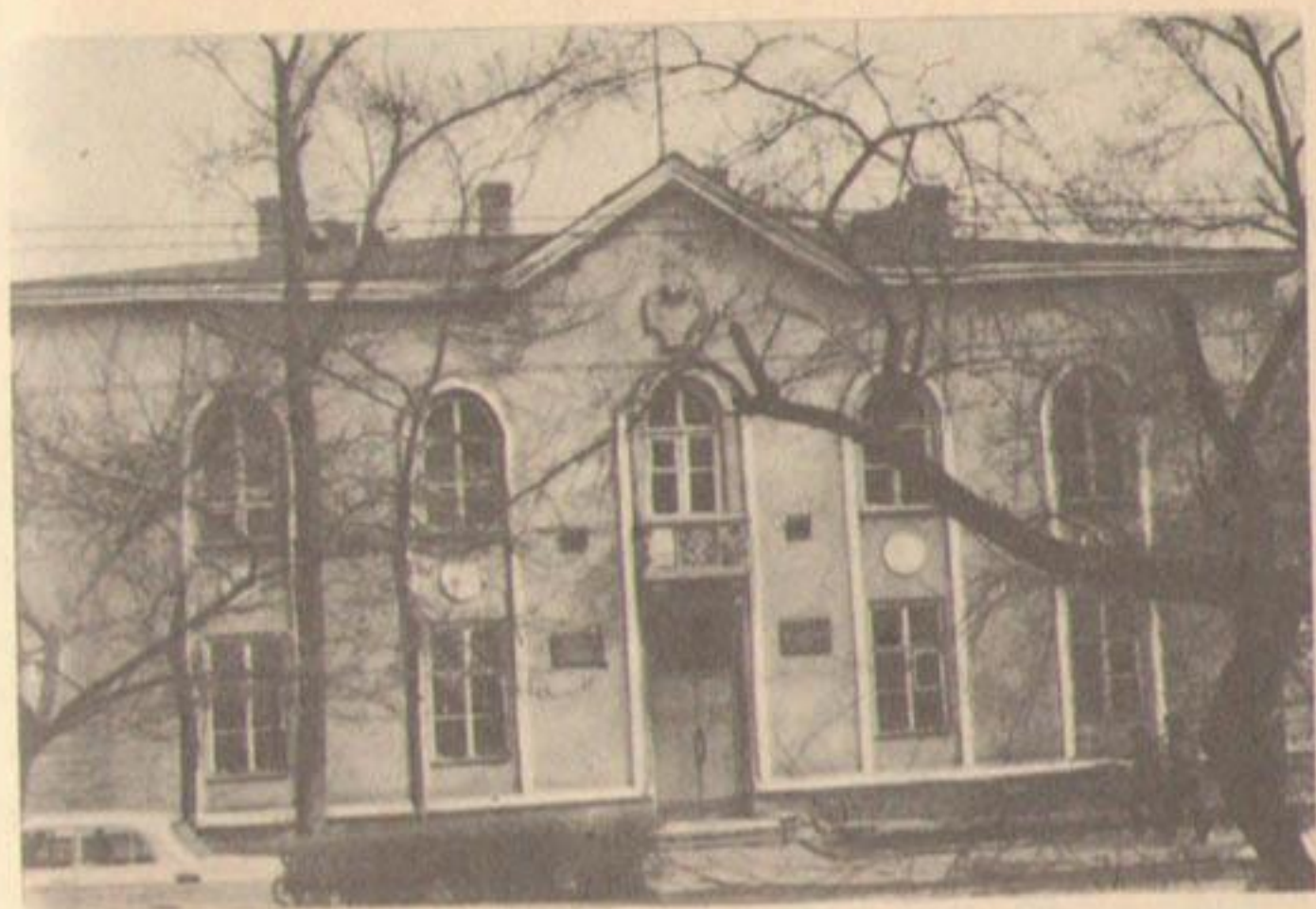
Административное здание Ортокою БЧКстрой по ул. Московской.
