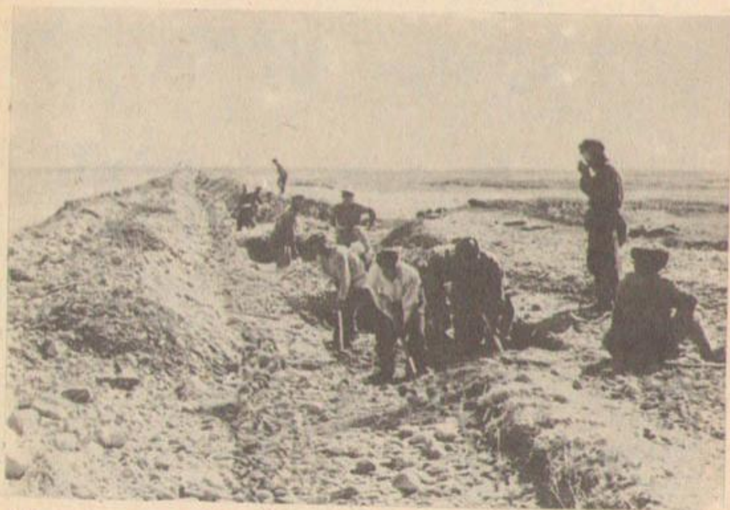
Канал Суусамырский. Подготовка земляного русла.
