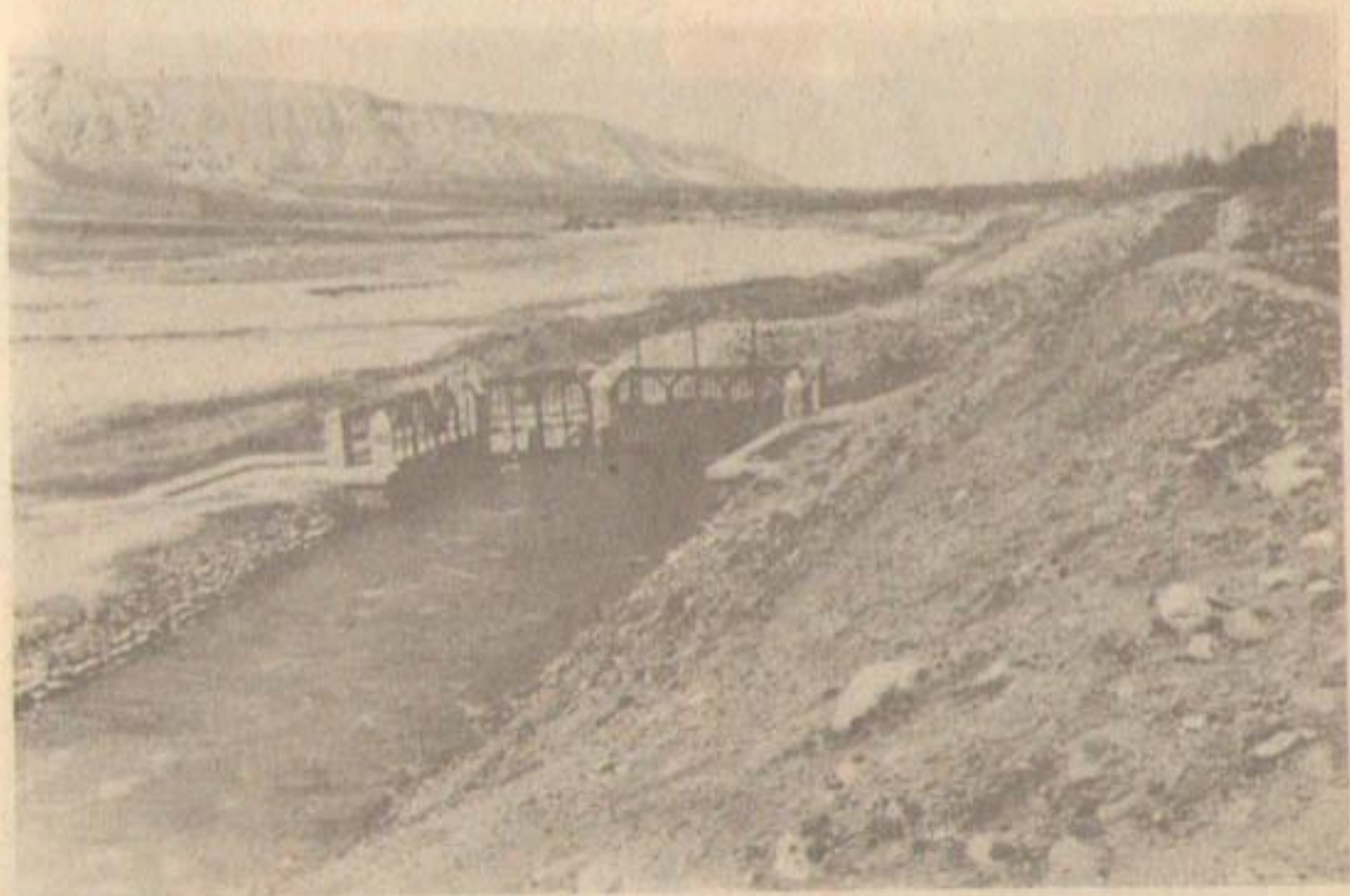
Главной регулятор на канале Ивановский.
