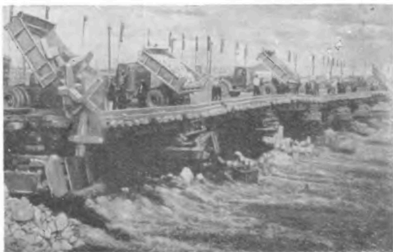
Рис. 34. Фото каркасной наброски Горьковгэсстроя.
