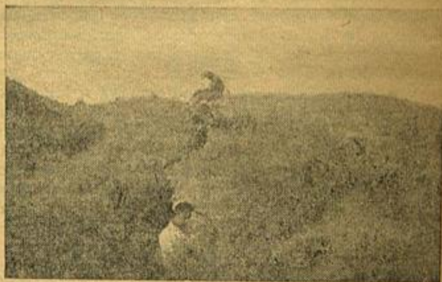
Рис. 2. Трещина оседания на канале Старый Джун
