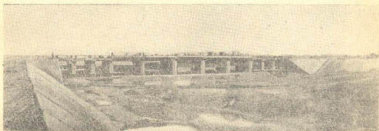
Рис. 46. Тешикташская плотина на Карадарье до монтажа затворов.
