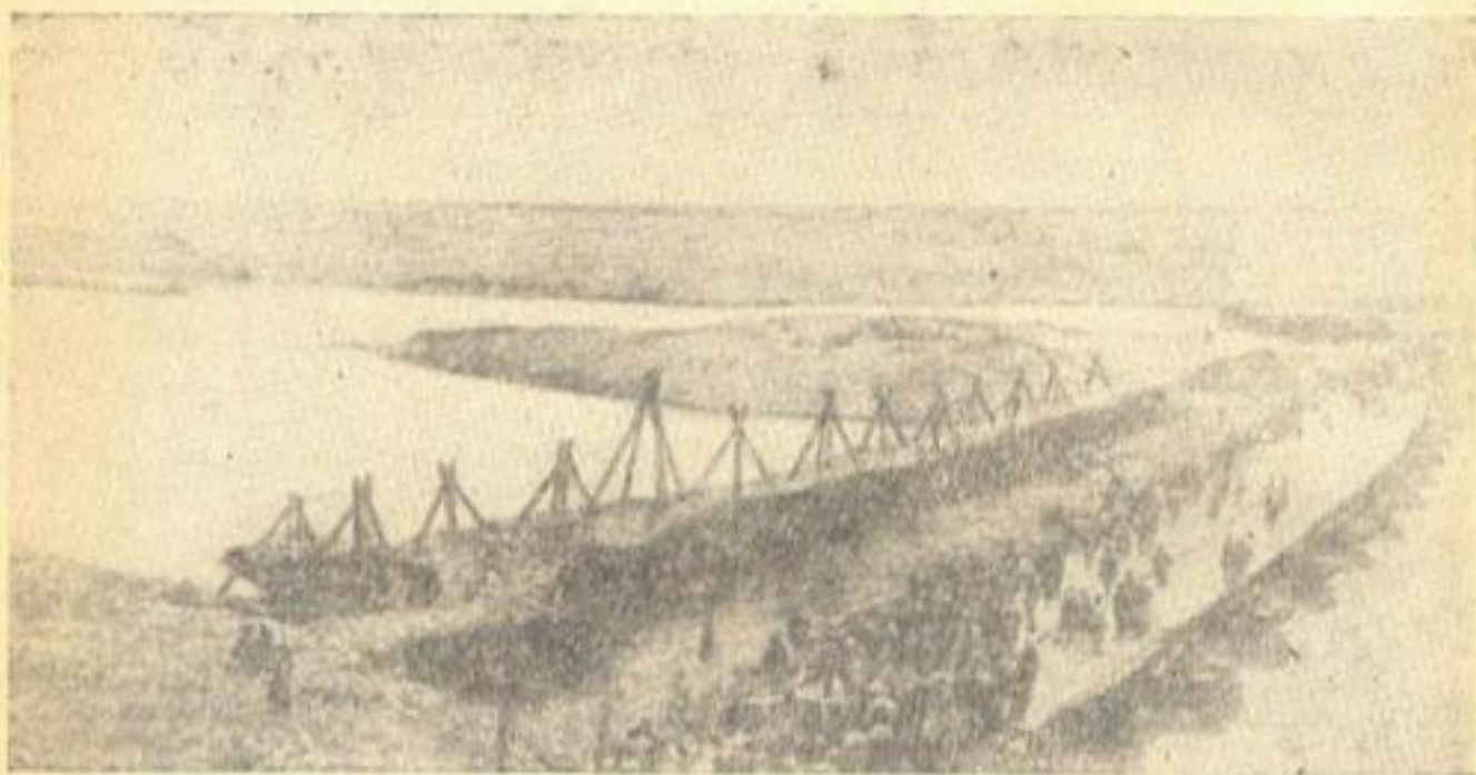
Рис. 38. Перекрытие в 1944 г. Сырдарьи на Фархалстрое.
