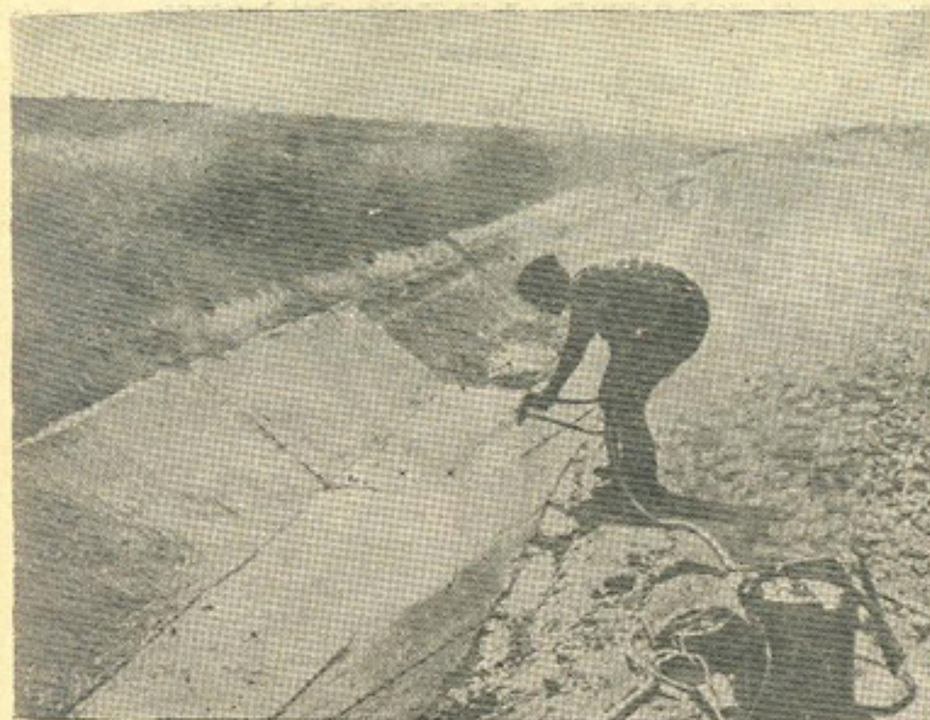
Рис. 30. Механизированное набрызгивание пленкообразующего покрытия.
